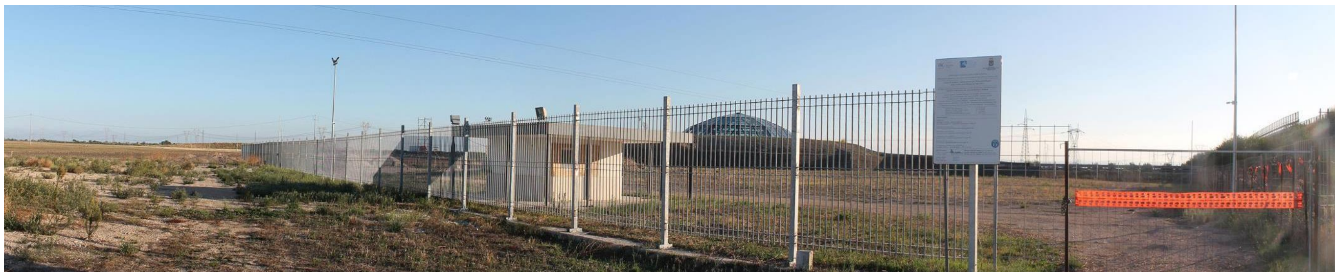
Le viste mostrano gli elementi che caratterizzano l'attuale paesaggio dell'area vasta circostante quella di impianto: in alto, infrastrutture elettriche e palificazioni nella zona archeologica di Arpi, nei pressi di Arpinova; torre d'acqua (al centro) lungo la SS 89 prima dell'incrocio per il borgo di Arpinova; in basso, la struttura realizzata a protezione dell'ipogeo della Medusa, in prossimità dell'Autostrada A14.
