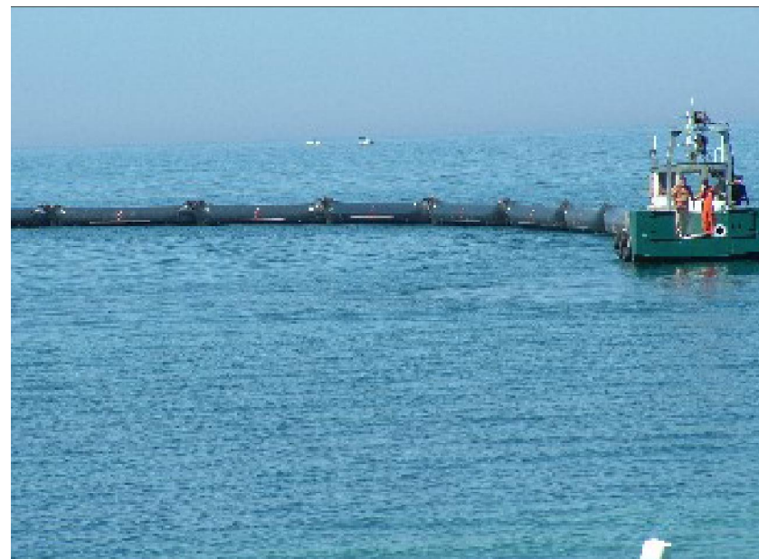
Schermo di protezione rappresentazione della fase di separazione e confinamento dell'area interessata dal dragaggio con panne, dotate di gonne.
