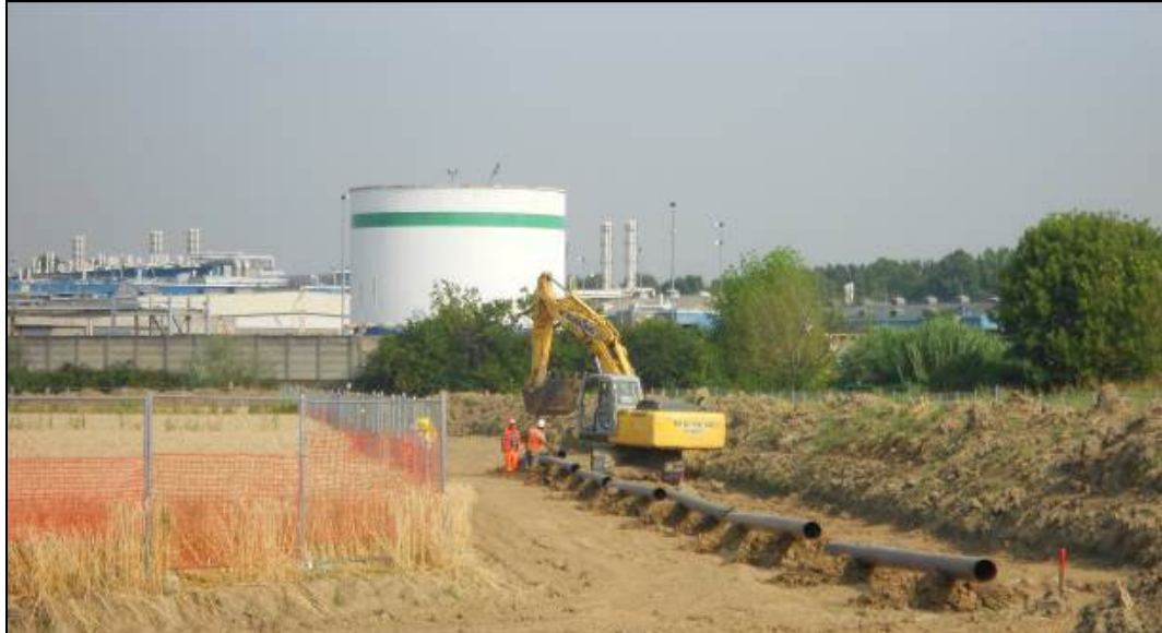
Fig. 8/C: Sfilamento tubi
