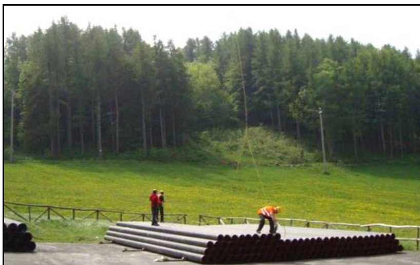
Fig. 8/A: Piazzola di accatastamento tubazioni
