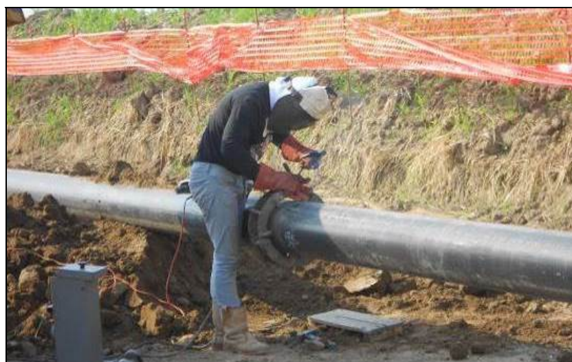
Fig. 8/D: Saldatura della tubazione
