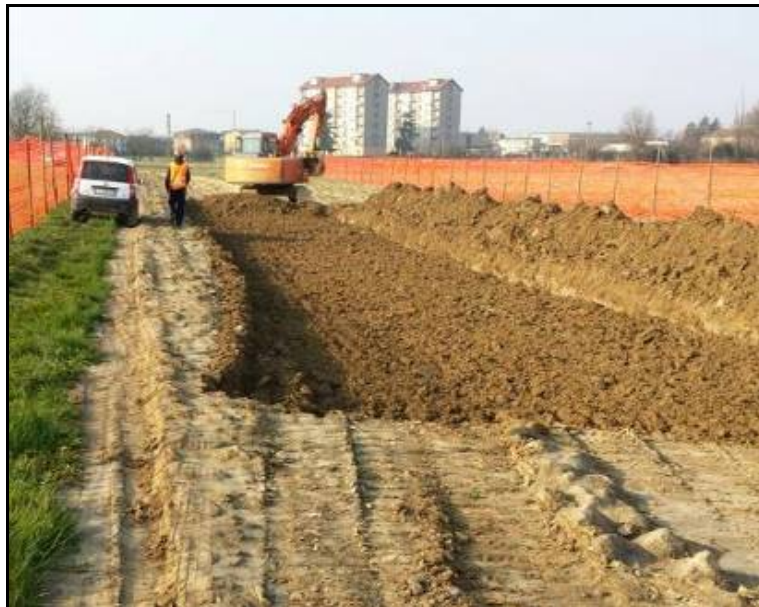
Fig. 8/B: Apertura della pista di lavoro
