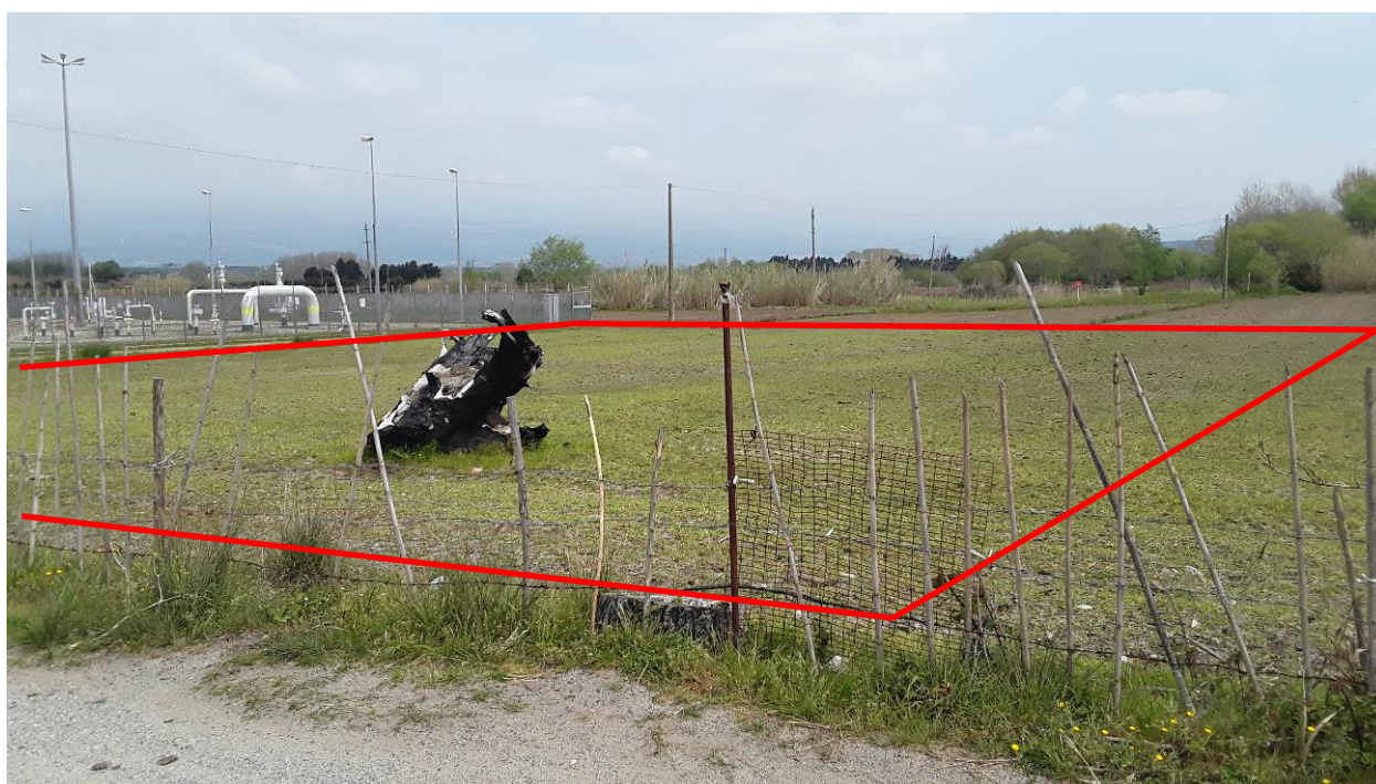
Foto. 11.5/B – Foto 2 -- Localizzazione impianto (in rosso) e Impianto di Regolazione di Palazzo
