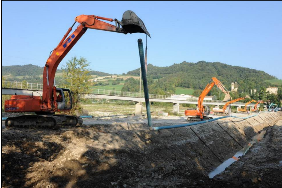
Fig. 8/F: Posa della condotta
