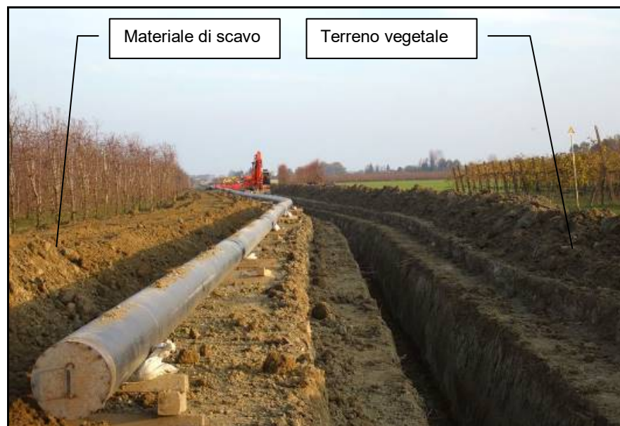
Fig. 8/E: Scavo della trincea
