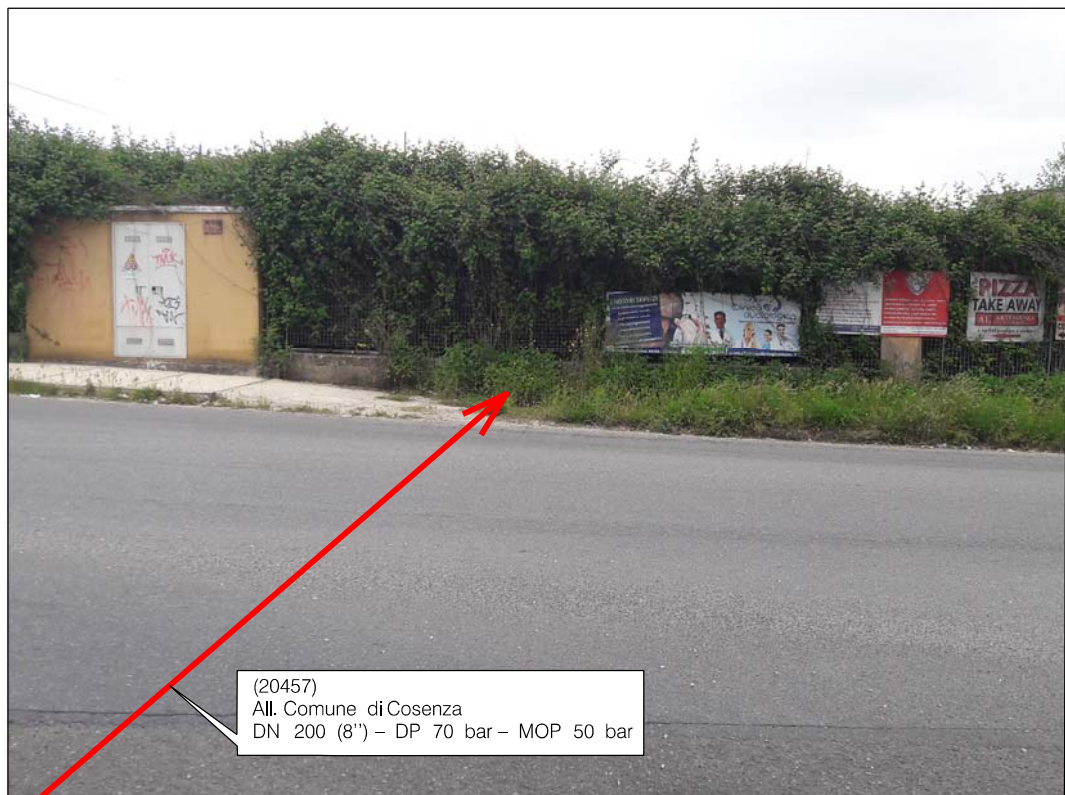
Attraversamento Via Metaponto in prossimita' dell'incrocio con Via degli Stadi nel territorio di Cosenza
