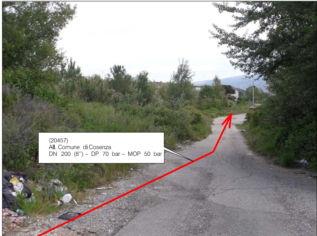
Vista s.g. uscita Trenchless e inizio percorrenza su Via Metaponto
