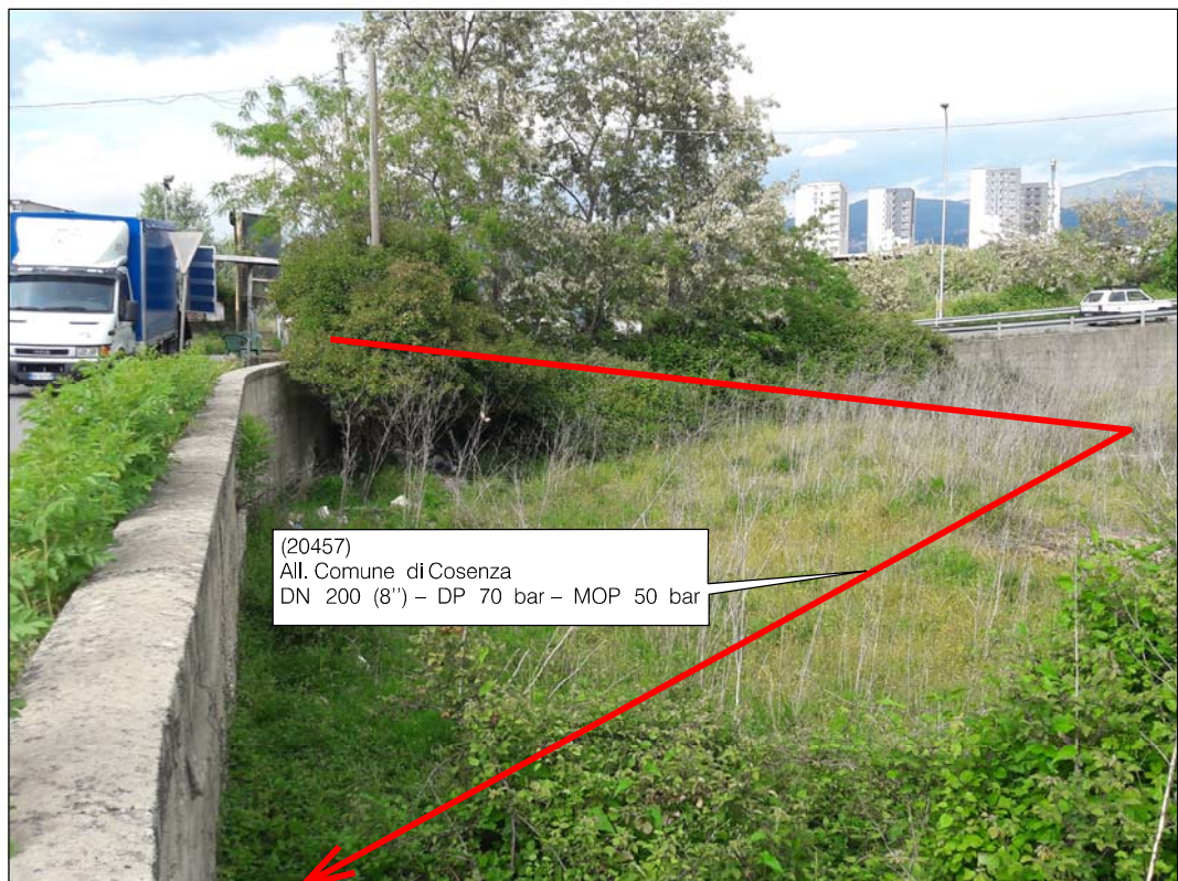
Vista s.g. Attraversamento Via Metaponto in prossimita' dell'incrocio con Via degli Stadi
