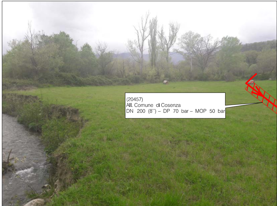
Vista c.s.g. Percorrenza in territorio incolto e Ingresso Trenchless in Comune di Castrolibero
