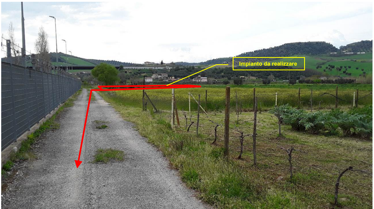
Fig. 4.3/C – Foto 2 -- Localizzazione impianto e recinzione Centrale di Tarsia (in rosso)
