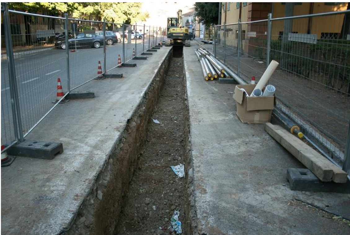
Figura 7.1-4 Scavo trincea per posa tubazione
