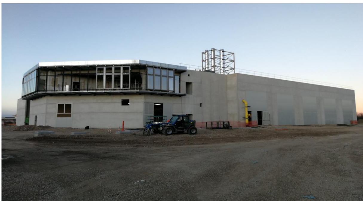
Figura 6.2-1 Centrale Sud in corso d'opera
