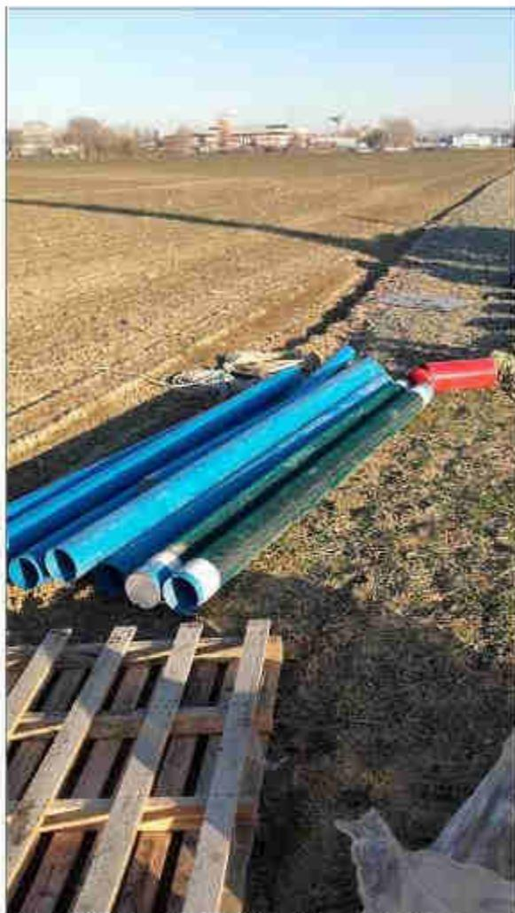
Piezometri (diam. 5") installati nel foro di carotaggio
