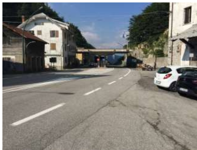
Figura 3.4-6 Confine con l’Austria (non presidiato), fotografia
