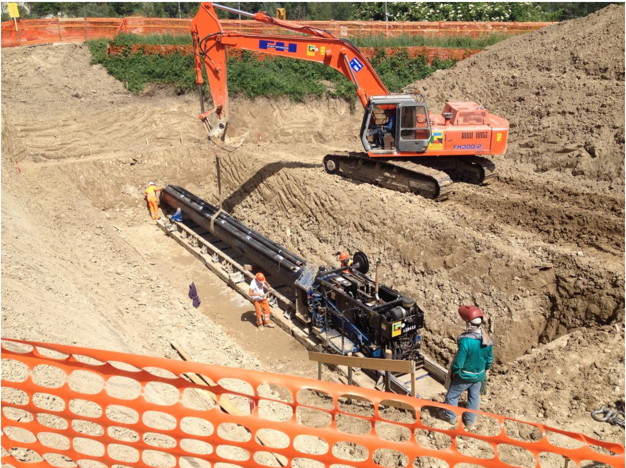
Fig. 3-8: trivella spingitubo.
