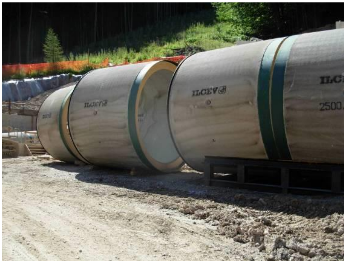
Fig. 3-14: Stoccaggio tubi in c.a.
