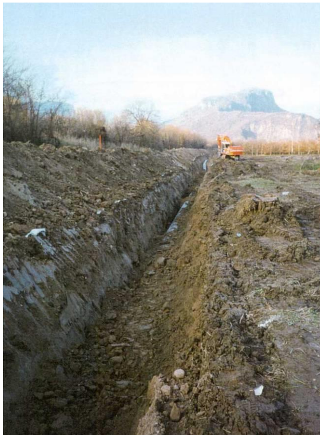
Fig. 3-5: Operazione di rinterro della condotta.
