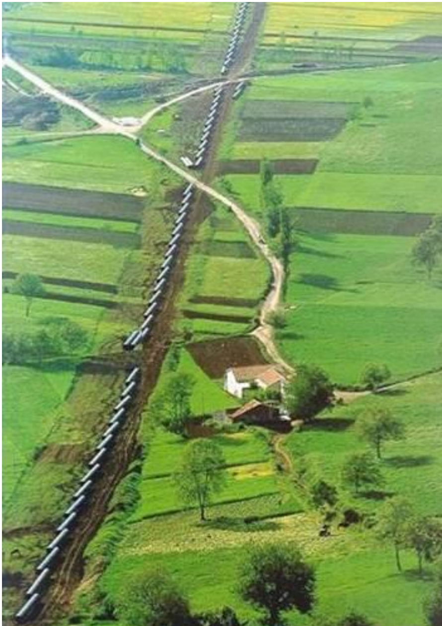
Fig. 3-1: Sfilamento dei tubi lungo la linea.
