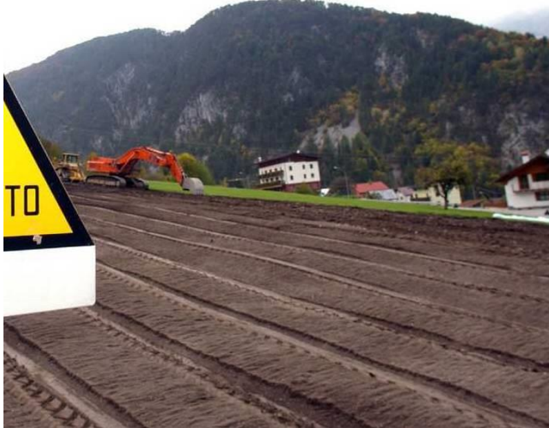
Fig. 3-6: Ridistribuzione dello strato humico superficiale.
