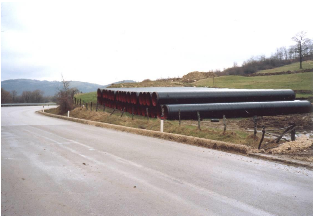
Fig. 3-6: Piazzole di accatastamento tubazioni.
