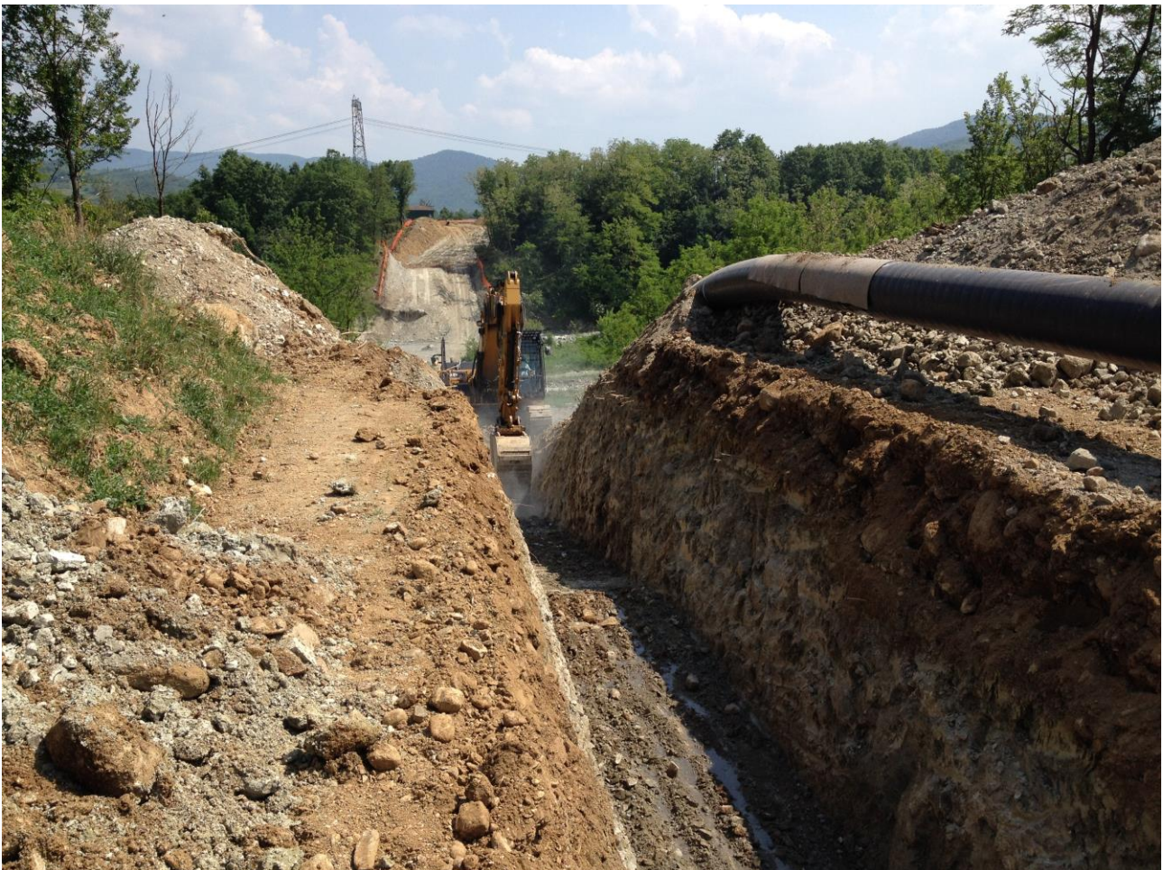
Fig. 3-3: Scavo per l'alloggiamento della condotta.
