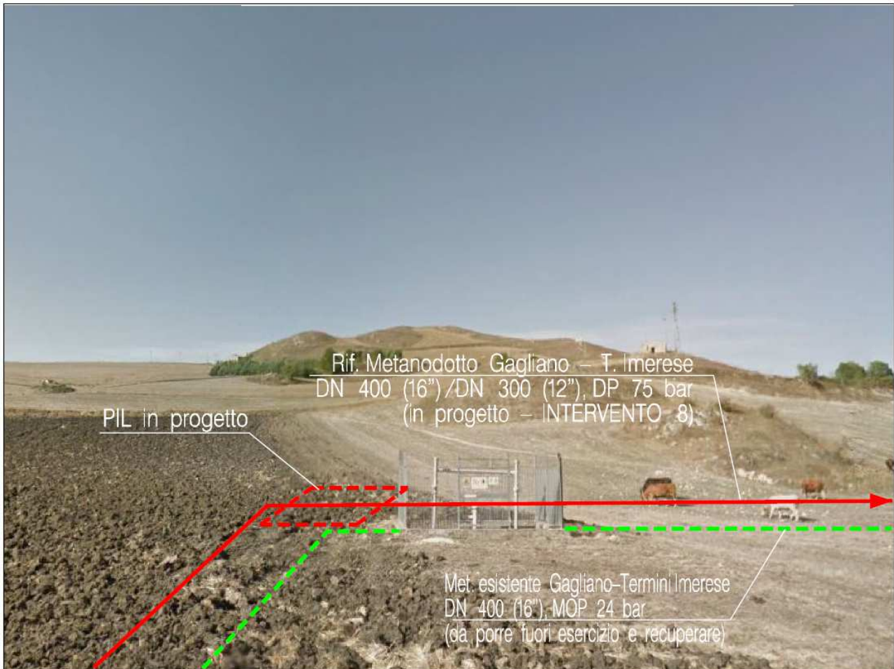
Figura 16 – Impianto esistente 45670/10.1 da rimuovere e nuovo PIL in Località Contrada Balate
