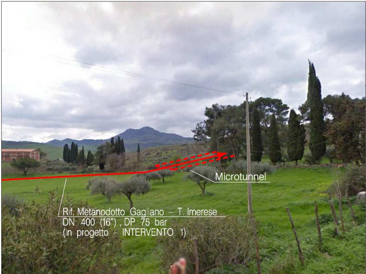
Figura 8 – Percorrenza zona “Masseria Ficilino” e ingresso Microtunnel
