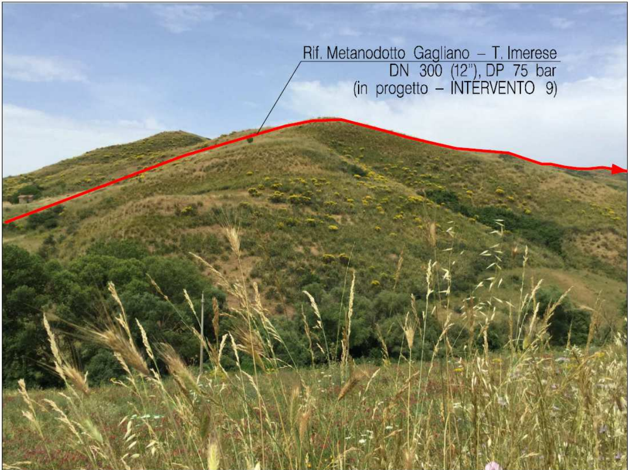
Figura 18 – Risalita dopo TOC Pagliuzza.
