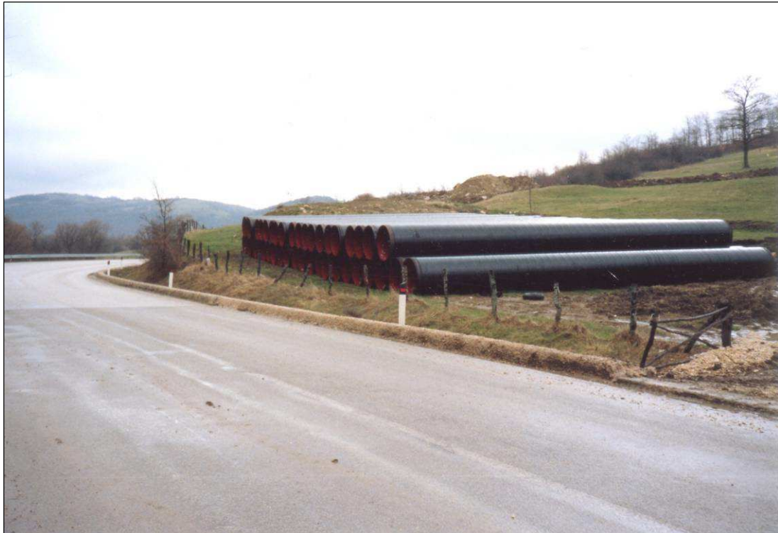
Fig. 1-27: Piazzole di accatastamento tubazioni.
