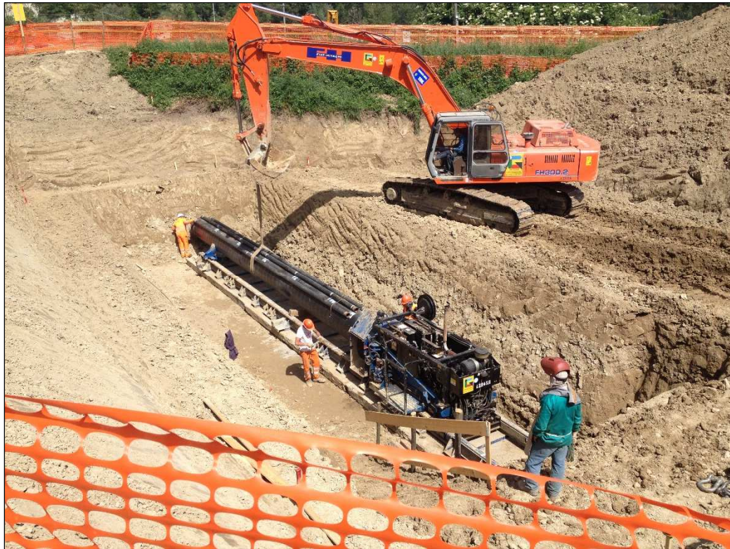
Fig. 1-37: Trivella spingitubo.
