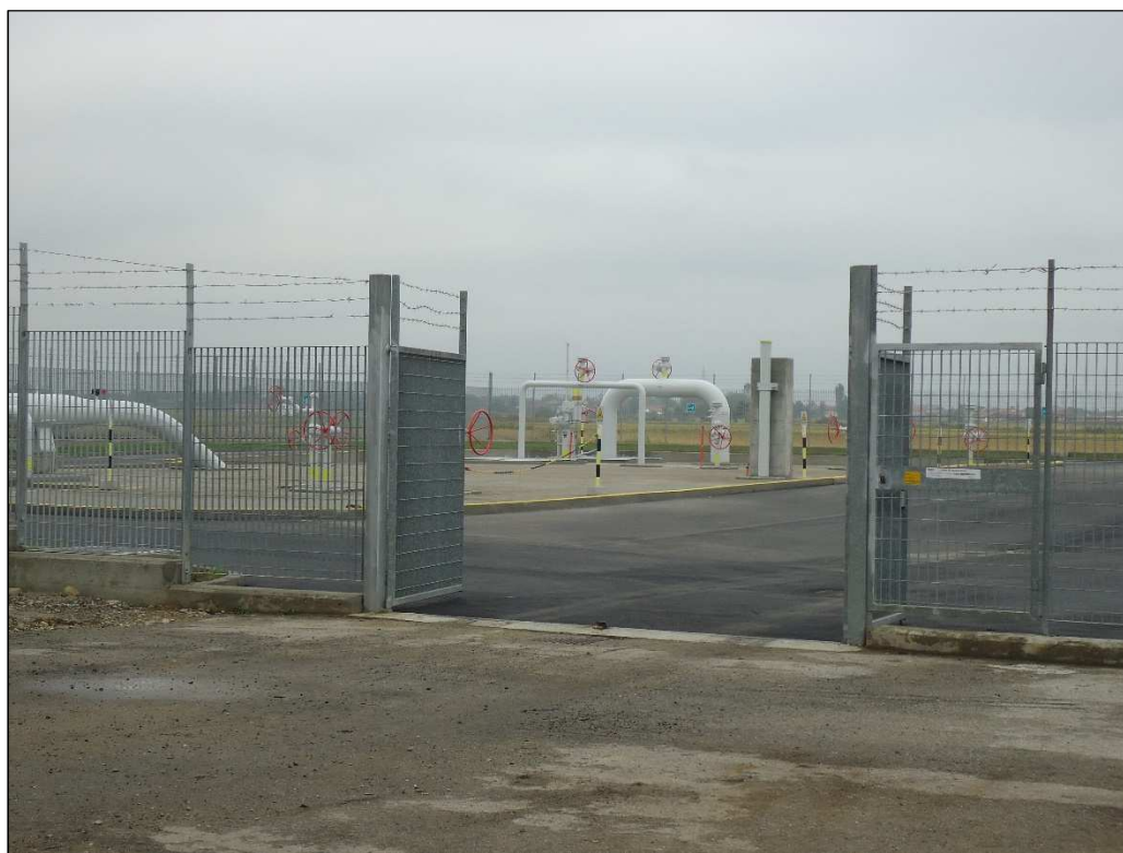
Fig. 1-26: Esempio di stazione lancio e ricevimento PIG.
