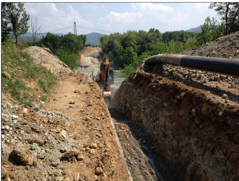
Fig. 1-30: Scavo per l’alloggiamento della condotta.
