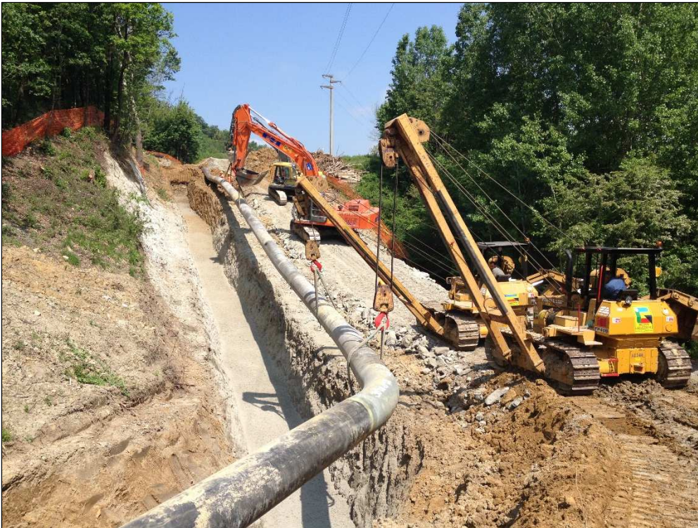
Fig. 1-31: Sollevamento e posa della colonna.
