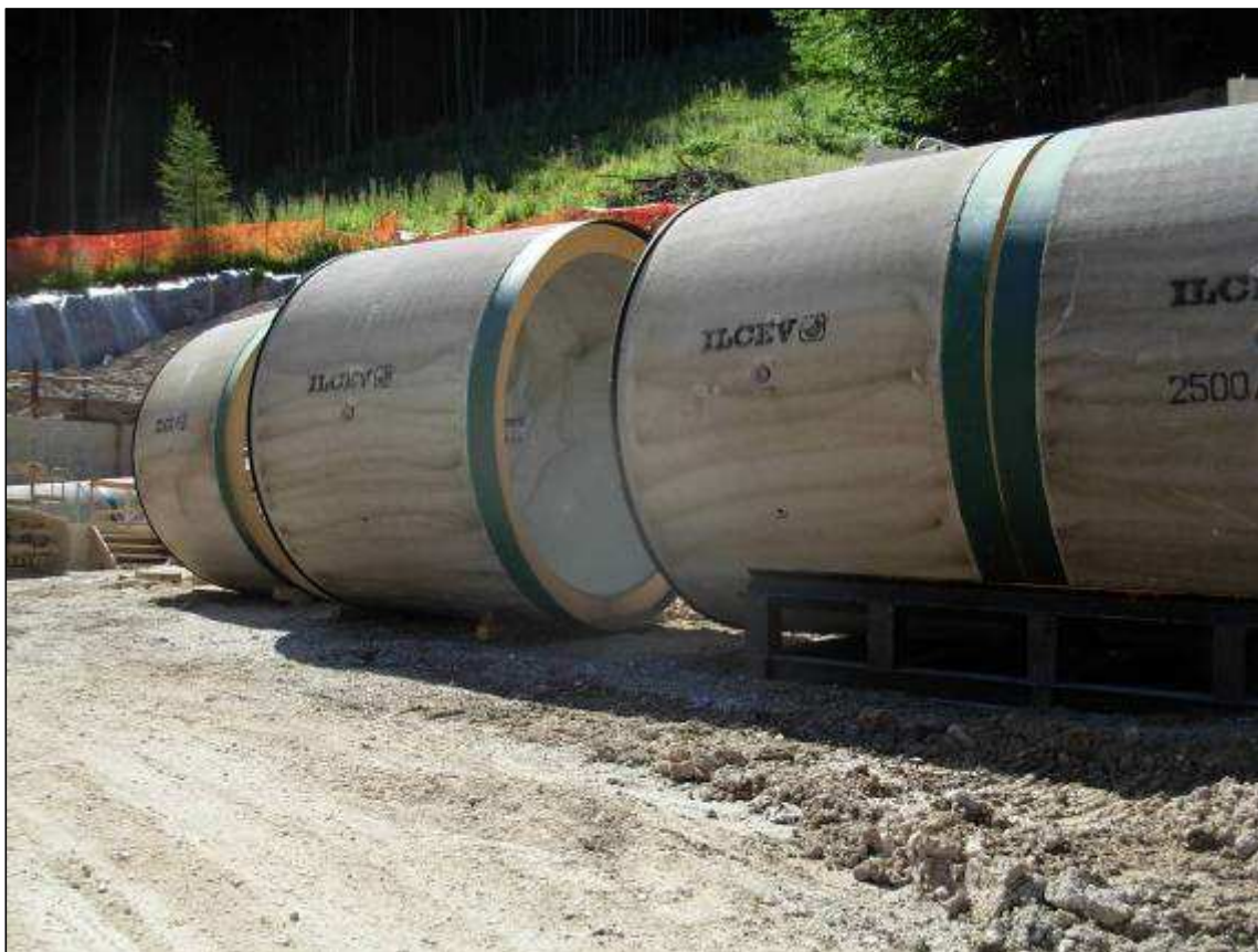
Fig. 1-44: Stoccaggio tubi in c.a.
