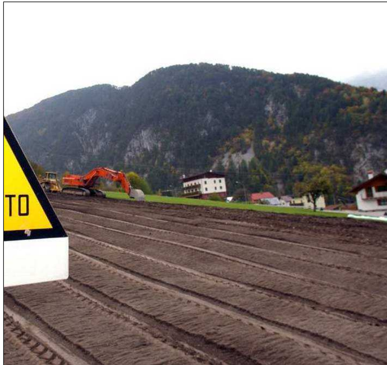
Fig. 1-33: Ridistribuzione dello strato humico superficiale.
