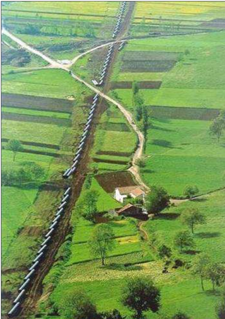
Fig. 1-28: Sfilamento dei tubi lungo la linea.
