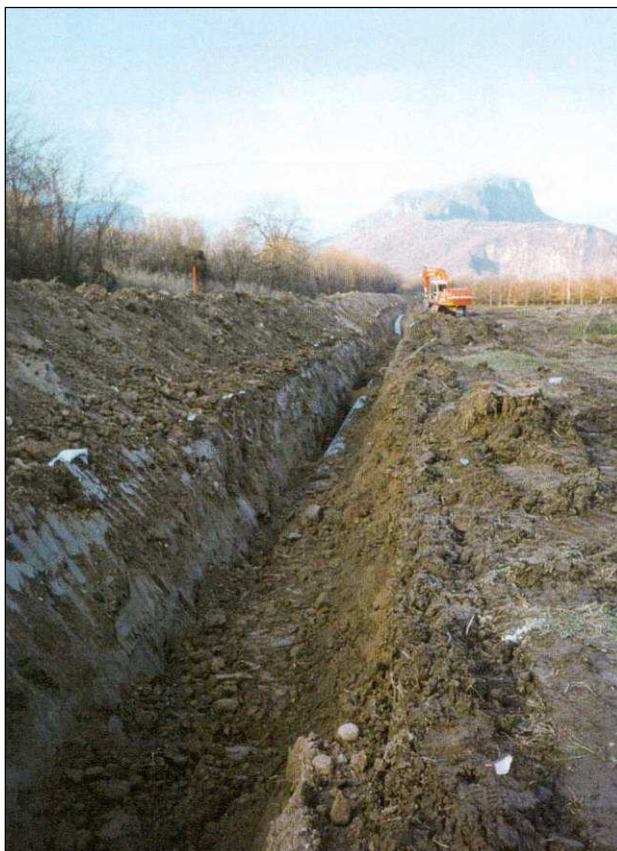
Fig. 1-32: Operazione di rinterro della condotta.
