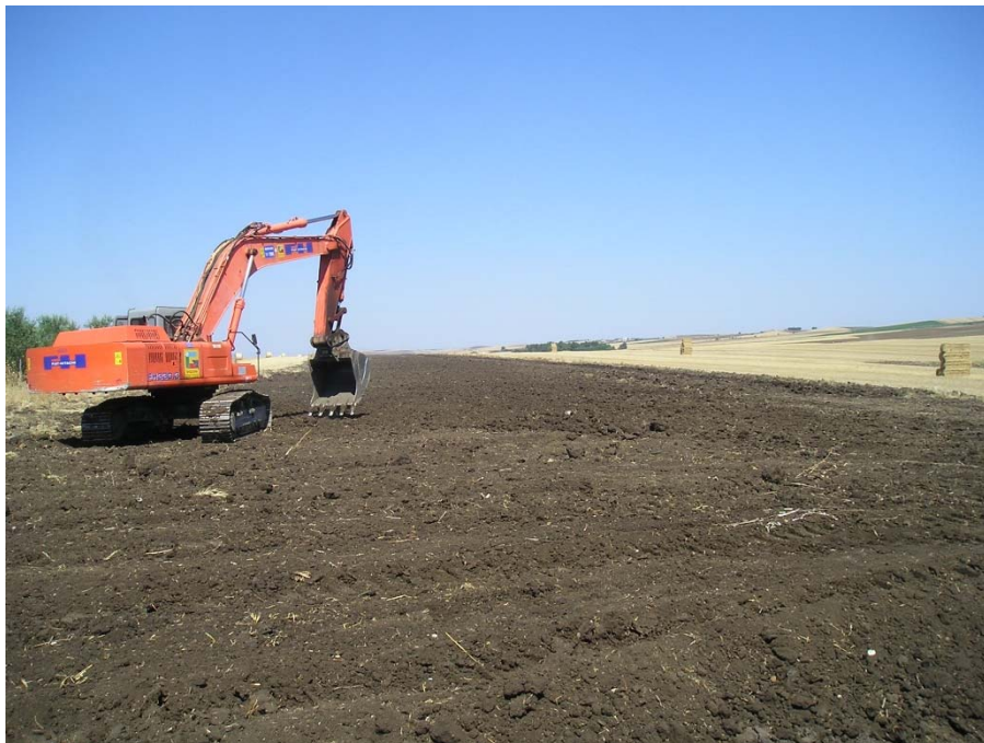
Fig. 1.3/D: Riposizionamento del top soil
