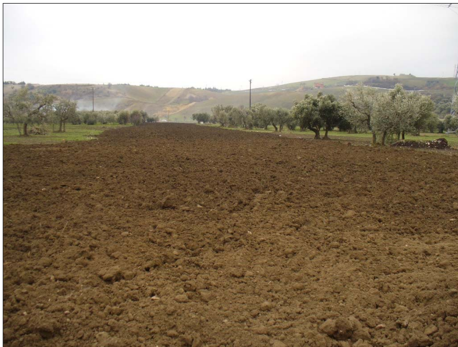
Fig. 1.3/E: Termine dei lavori con il top soil riportato. Successivamente si procede con il ripristino vegetazionale
