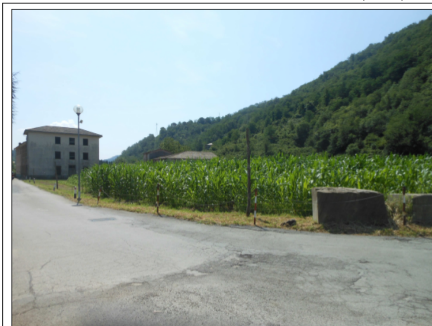
FOTO -1- Particolare Zona Stoccaggio Tubi in progetto
