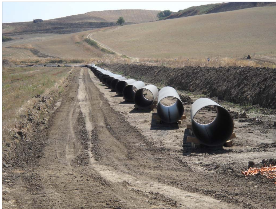
Fig. 1.3/A: Area di passaggio già realizzata con sfilamento tubi. Sulla destra si nota l'accantonamento del top soil, avvenuto in fase di apertura dell'area di passaggio
