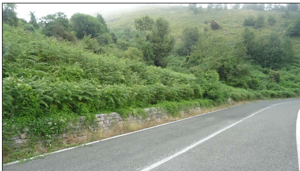
Foto 3.5/C: il muretto di contenimento in corrispondenza della linea da dismettere
