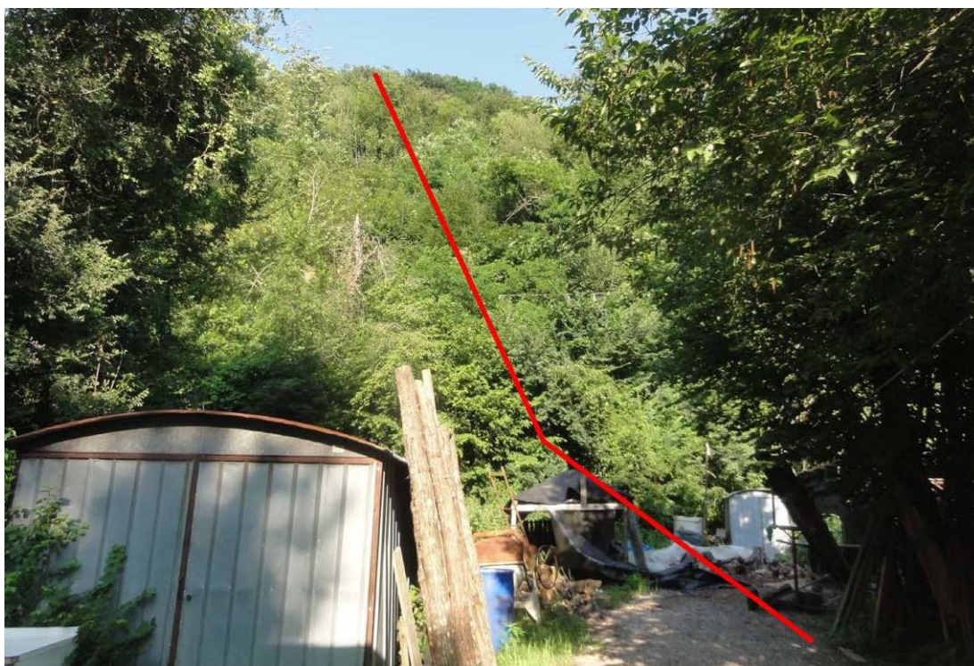
Fig. 5.3/I: Raise Boring "La Crocetta 2" (imbocco galleria)
