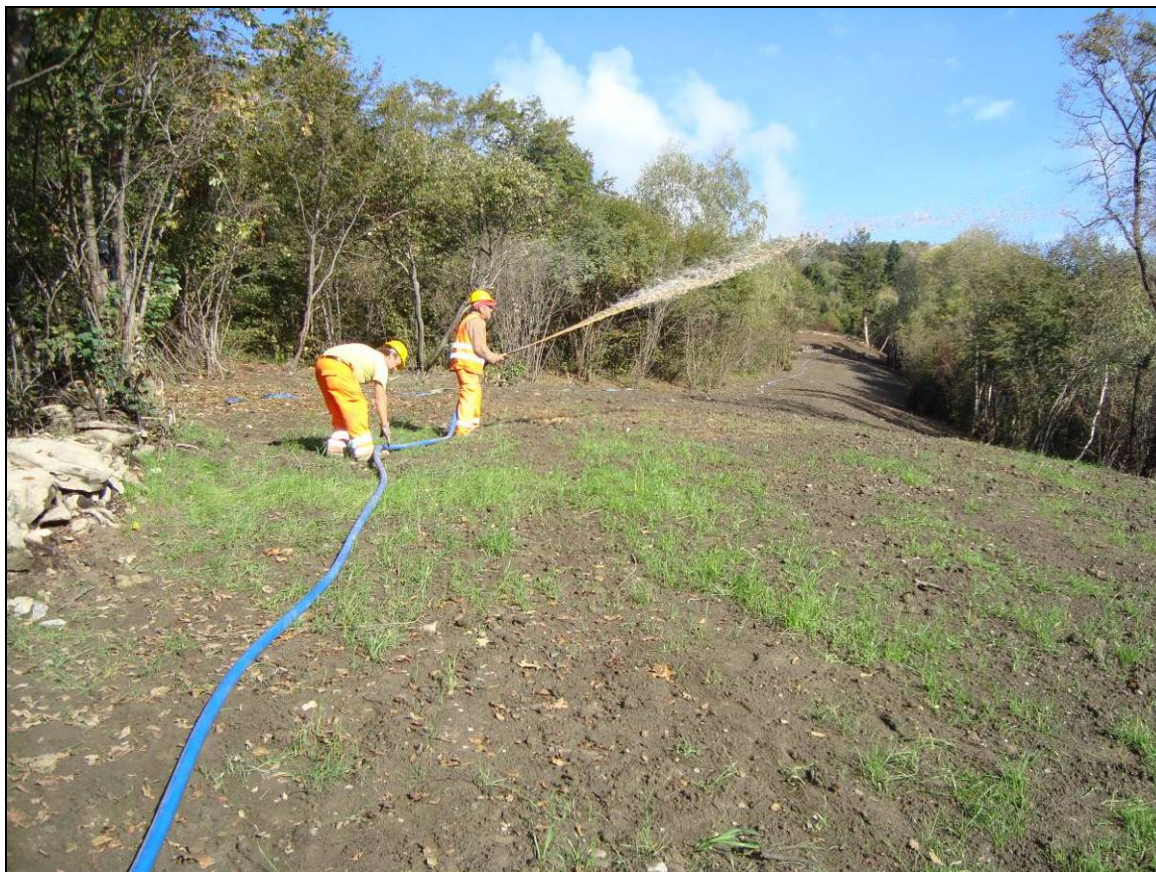
Foto 5.1/A: Distribuzione del miscuglio di semi per l'inerbimento e del quantitativo di fertilizzanti mediante Idrosemina
