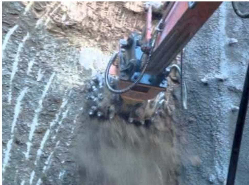
**Fig. 4/H: Fresa puntuale trasversale in azione**
