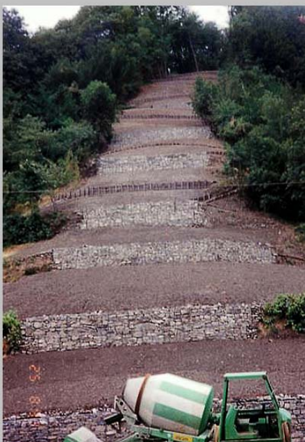
Recco - agosto 1993 ripristino terrazzamenti
