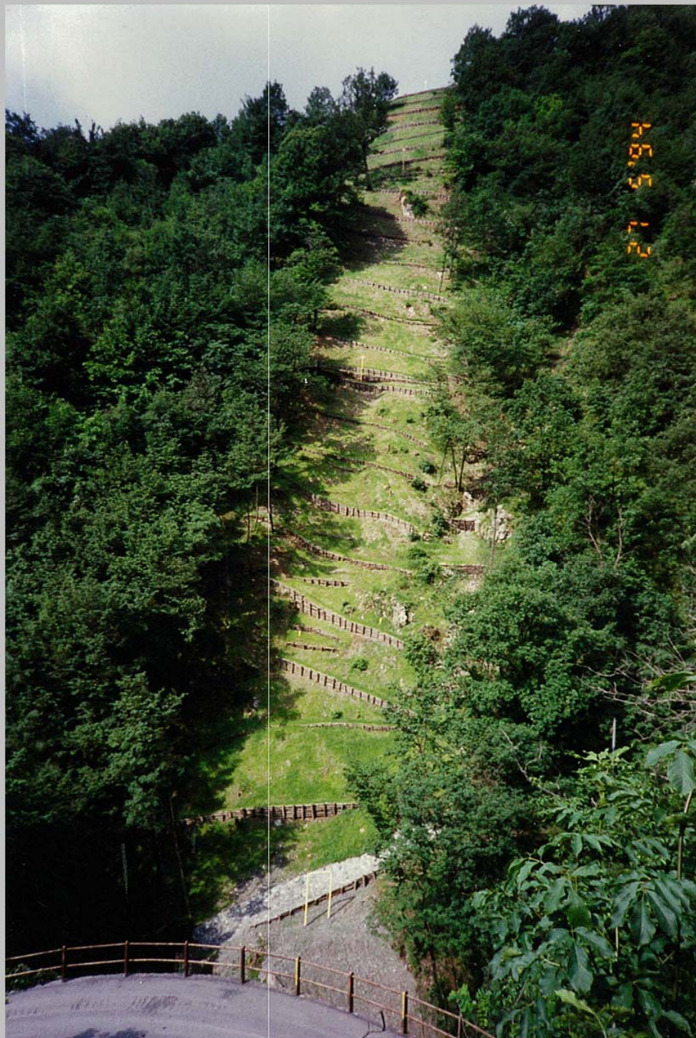
Interventi di ripristino morfologico e vegetazionale - inerbimento - anno 1994
