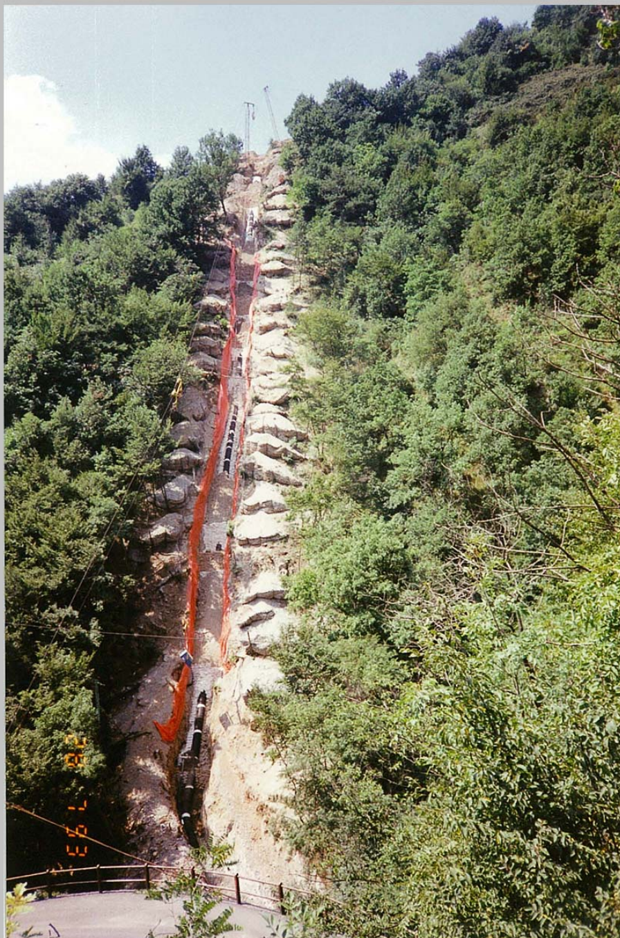
Posa di condotta su terreni con pendenze elevate - anno 1993
