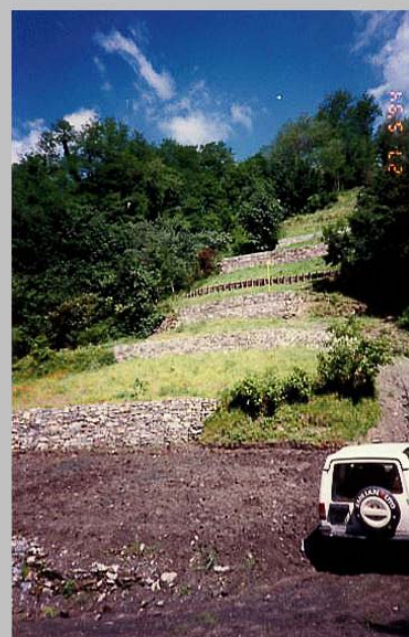
Recco - maggio 1994 ripristino terrazzamenti
