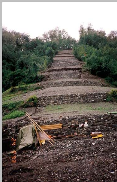
Recco - settembre 1993 ripristino terrazzamenti
