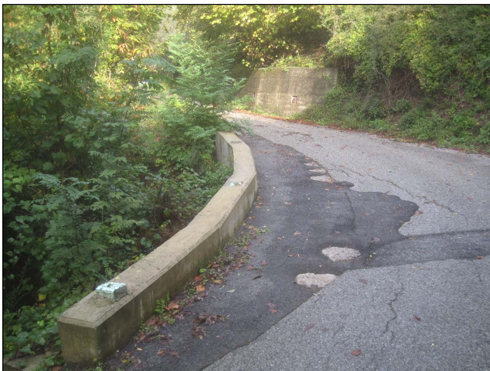
Fig 7/E: Attraversamento stradale dell'area Pg3a, corpo di frana a circa 197 m slm
