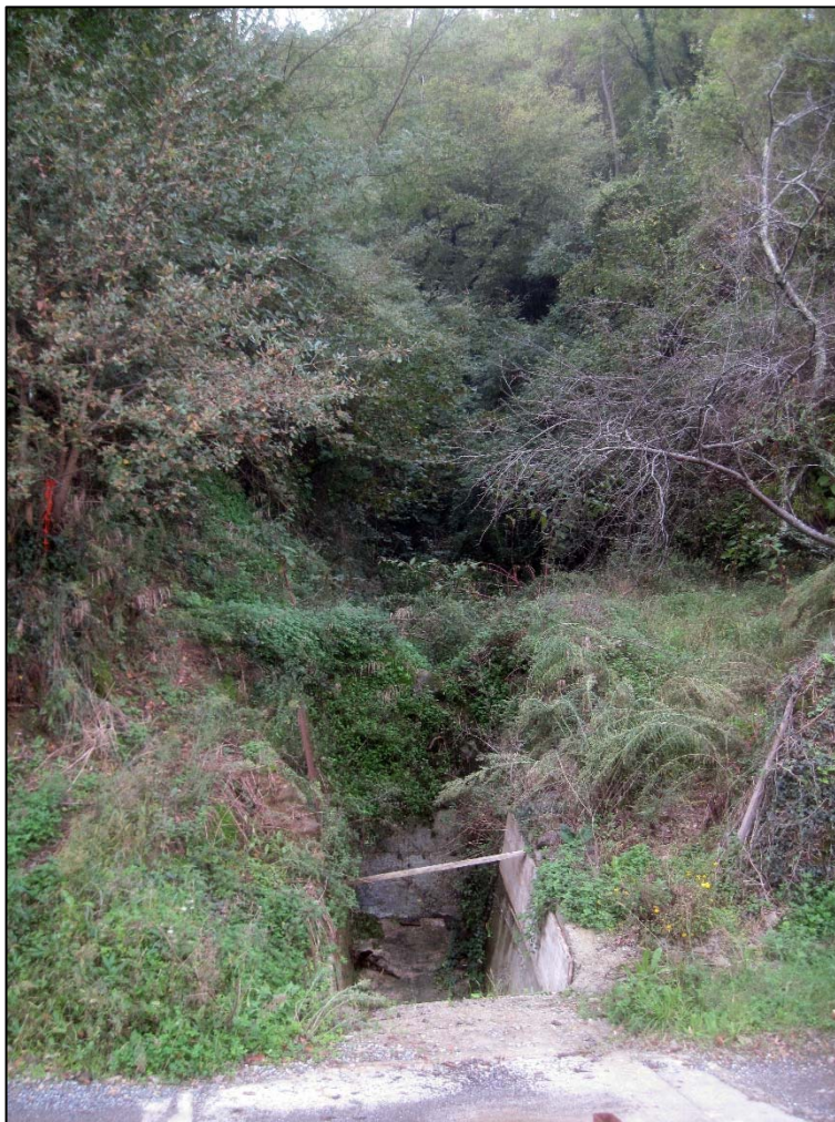
Fig. 10/C: Tratto terminale dell'area Pg4 allo sbocco della piana alluvionale dello Sturla
