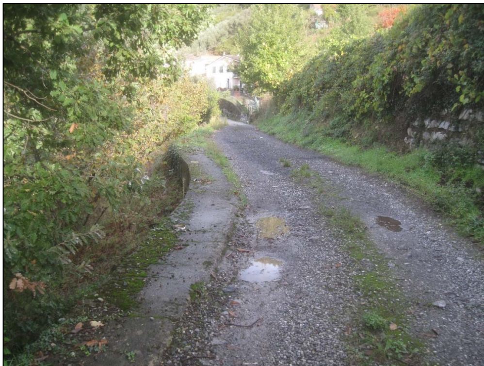
Fig. 7/D: Attraversamento stradale dell'area Pg3a, a circa 233 m slm
