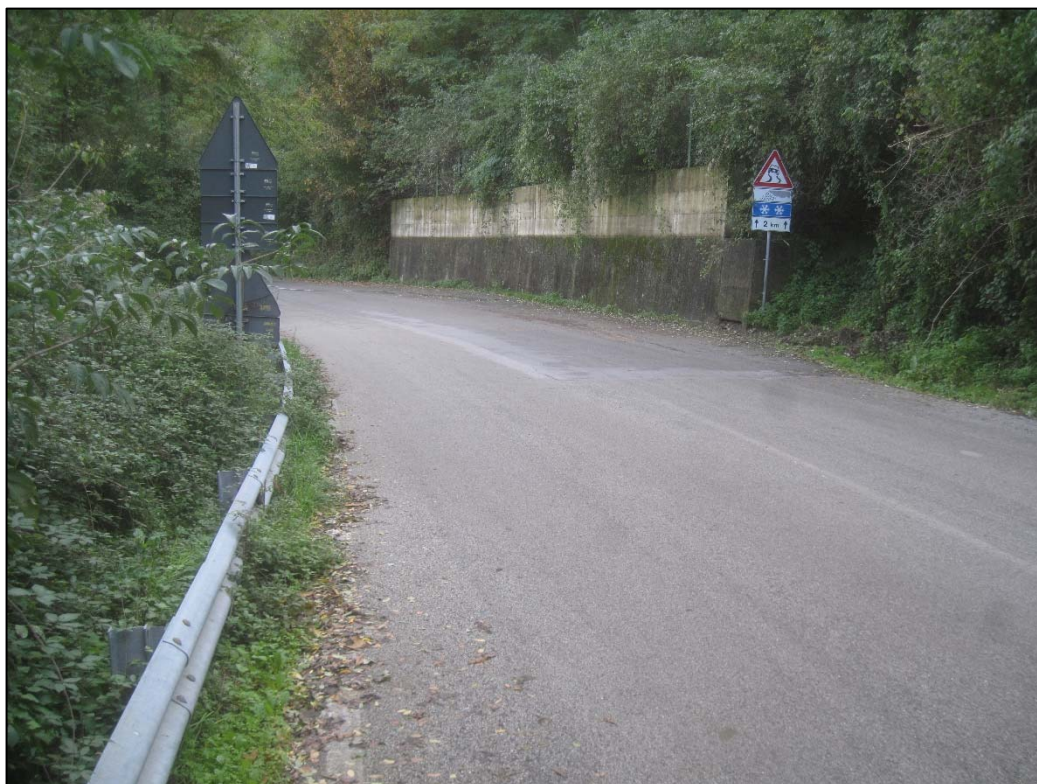
Fig. 15/C: Muro di contenimento in cls a valle dell'accumulo di frana
