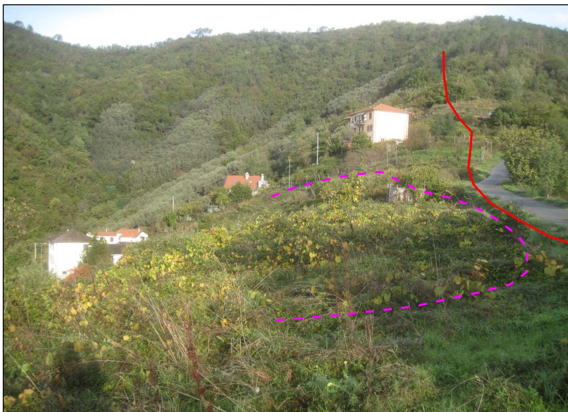
Fig. 7/C: Area Pg3A, settore del coronamento
