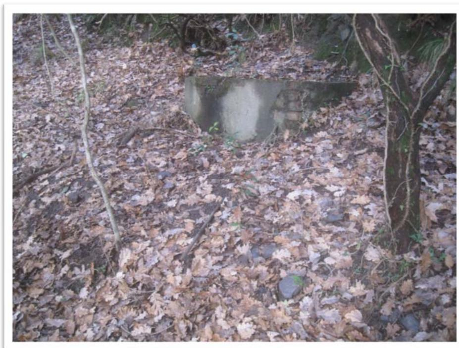
**Fig. 1.2/B: Bottino di presa abbandonato della sorgente SG19bis**
