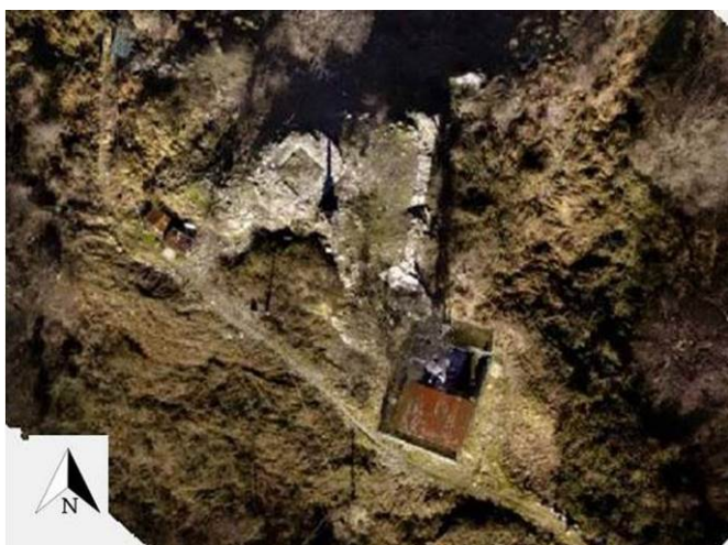
Figura 11 – Ortofoto con volo di drone
