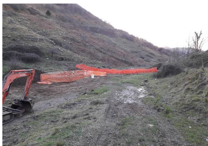
Figura 23 – Attività 7, area di cantiere
