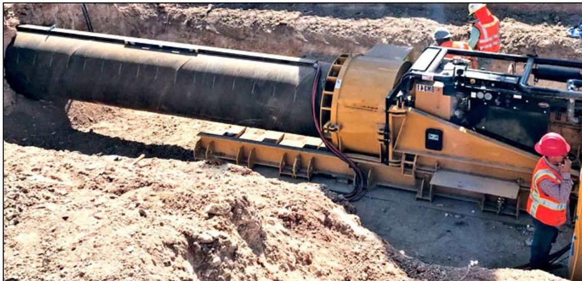
**Figura 3/C: esempio di pozzo di spinta con la macchina *thrust boring* in azione nel verso della sezione schematica in figura 3/B.**
