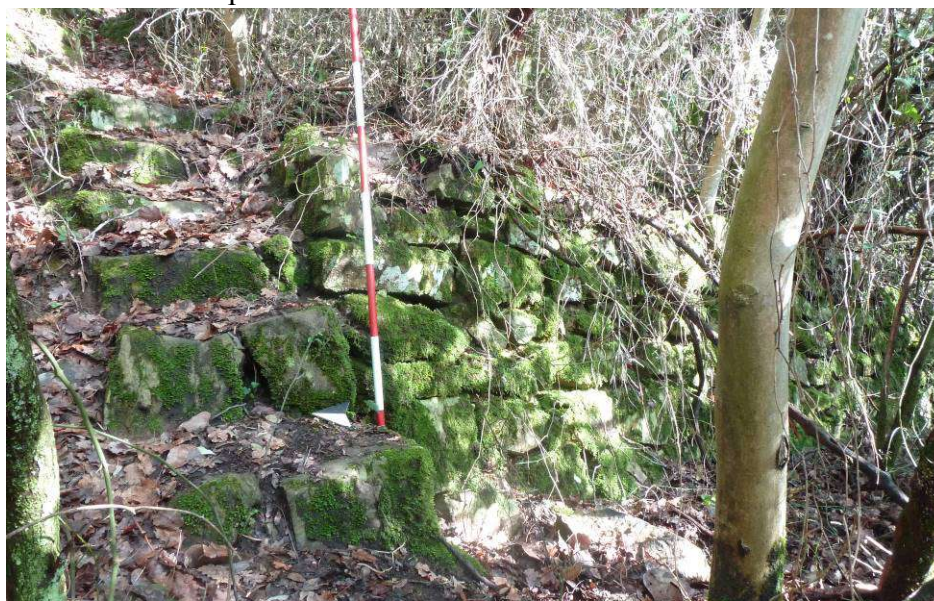
fig. 29 - Terrarossa UT 6057 scaletta laterale lungo i muri di terrazzamento
