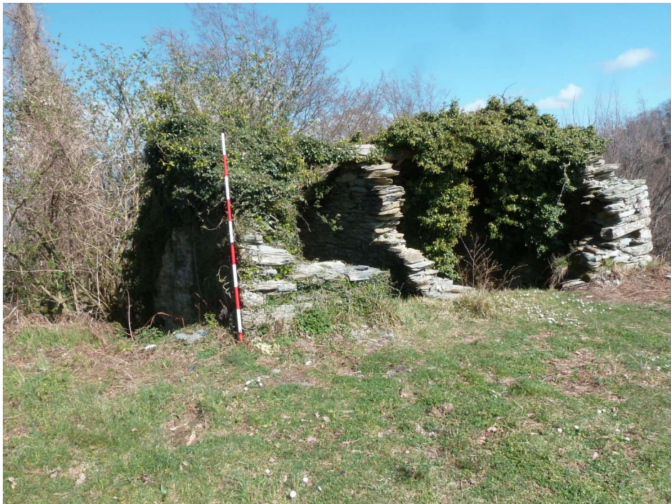
fig. 21 -Monte Rosso UT 7047 - resti di casoni in stato di crollo sul crinale
