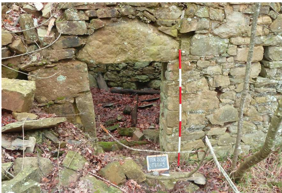
fig. 28 - Castagnola di Carnella UT 6013 apertura con architrave monolitico relativa al corpo di fabbrica più antico della struttura
