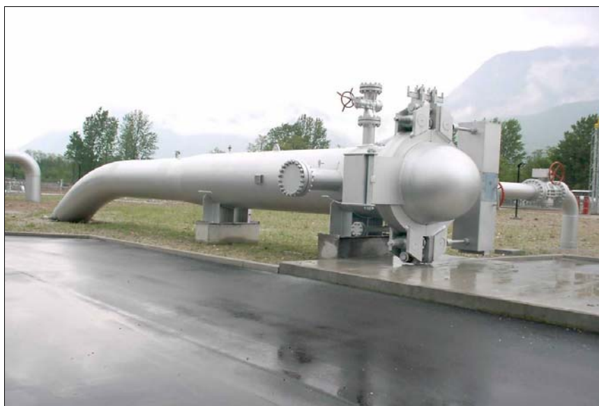
Foto 3.3/A: Punto di lancio e ricevimento pig
