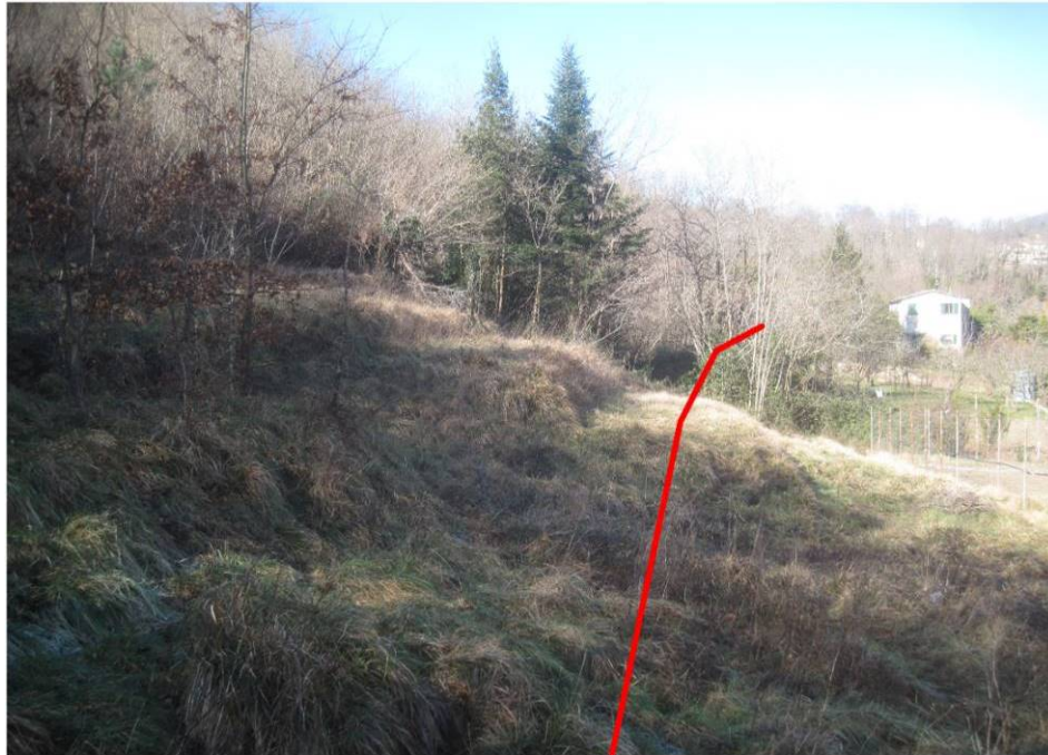
Foto 32: Pg3b: km 34,03 – 34.15. Attraversamento a mezza costa del versante
