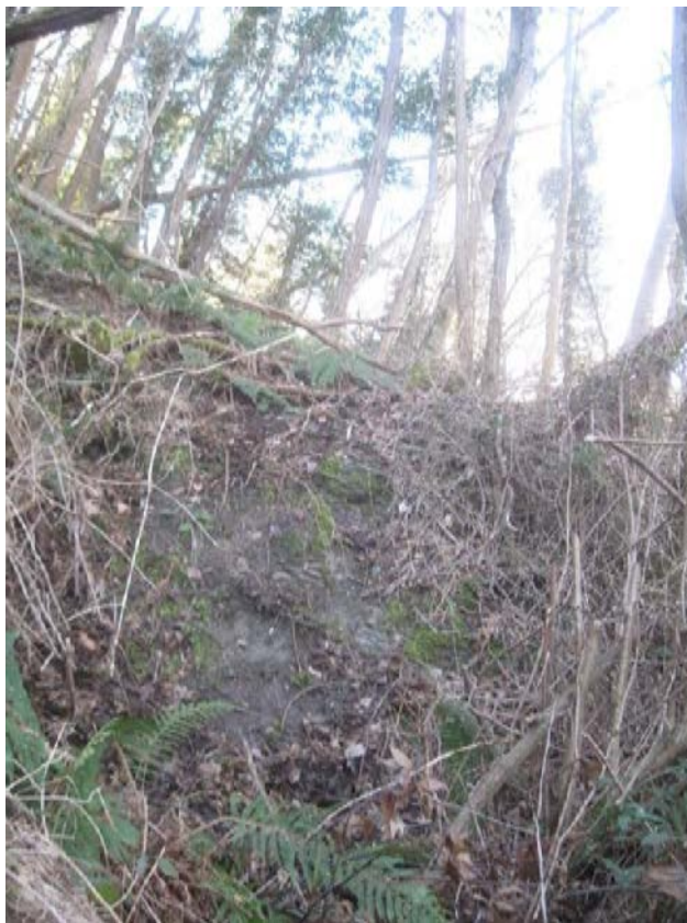
Foto 30: Pg3b km 33,44 – 33,55. Corpo detritico lungo l'attraversamento dell'area
