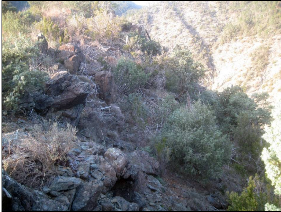
Fig. 3B/D: Area Pg3b. Orlo di degradazione sul versante Est
