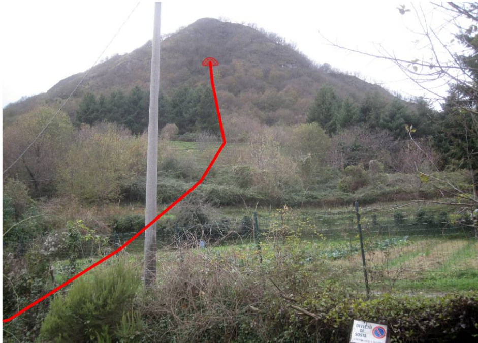
Pg3b: km 46,33-46,46 , km 46,49-46,51 . Risalita del versante NE del Monte Bado e imbocco del microtunnel.
