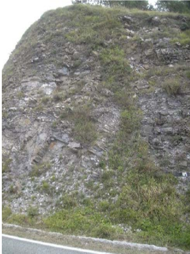
Foto 44: Scarpata stradale nell'area Pg3b km 0,79-0,94 (Collegamento IMP di Sori)
