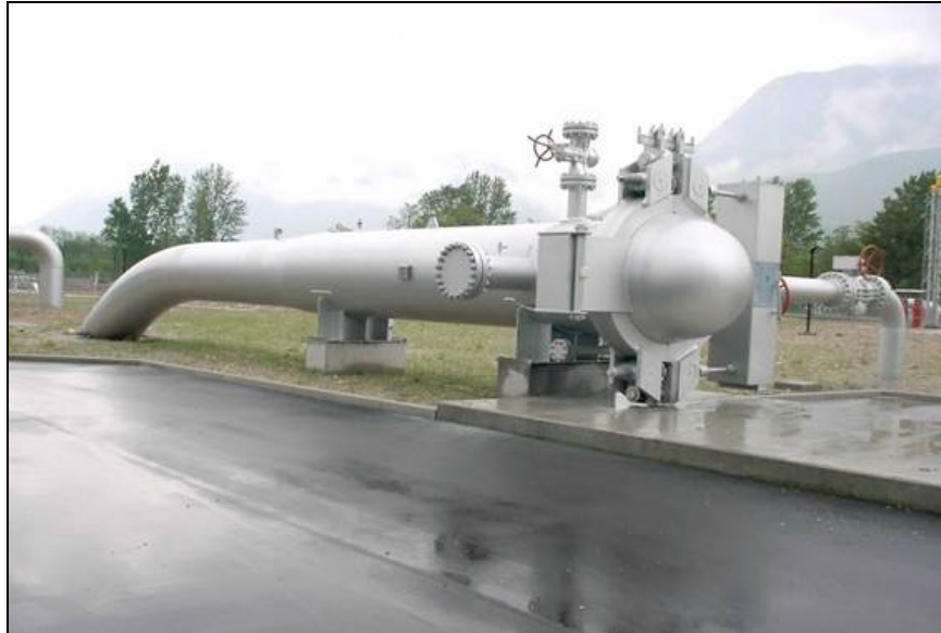
Fig. 2.2/A: Punto di lancio e ricevimento pig
