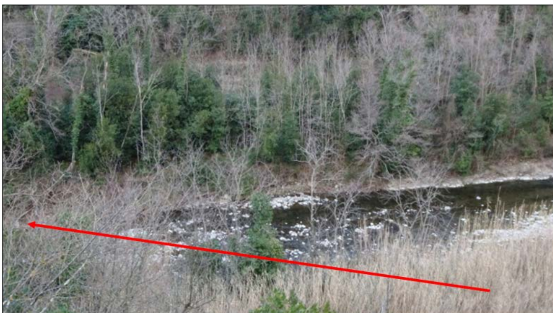
Fig. 3/B: Rappresentazione fotografica dell'alveo dello Sturla nella sezione di attraversamento in progetto
