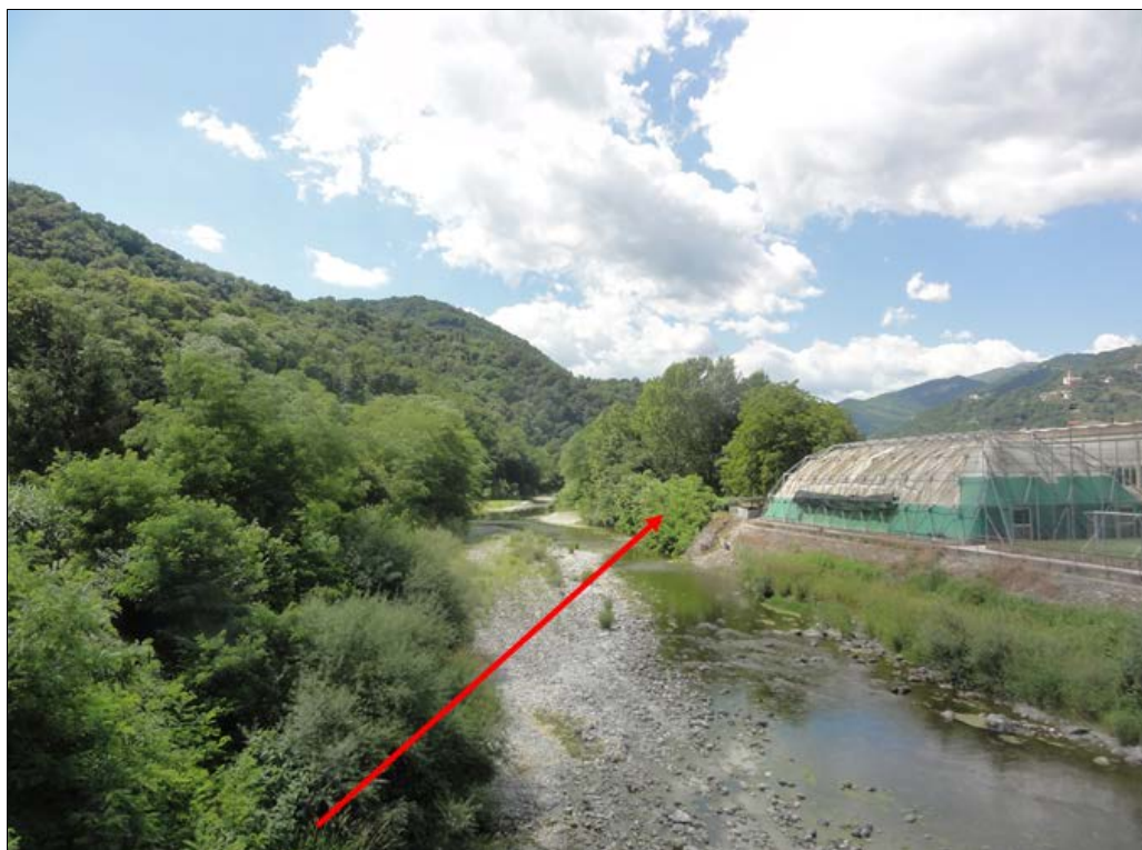
Fig. 3/B: Rappresentazione fotografica dell'alveo nella sezione di attraversamento #2 in progetto
