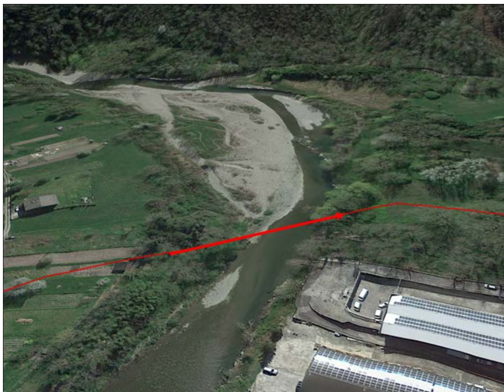
Fig. 3/A: Rappresentazione satellitare dell'alveo nella sezione di attraversamento #1 in progetto
