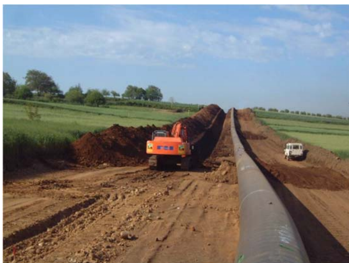
Figura 5 - Scavo in trincea
