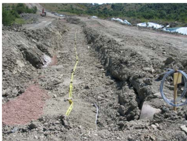
Figura 7 – Rinterro della condotta
