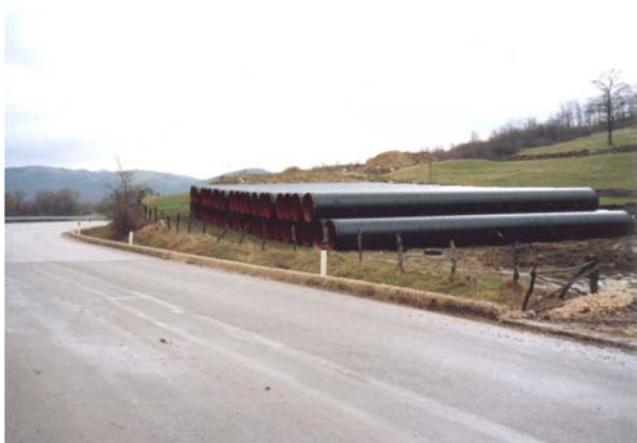
Figura 3 – Piazzola di accatastamento tubazioni
