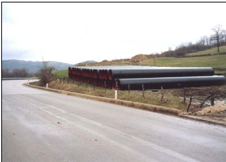
Foto 3.2/A: Piazzola per accatastamento delle tubazioni (esempio di tubi con diametro superiore alla linea in progetto)
