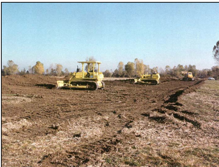
Foto 3.2/B: Apertura della pista di lavoro/passaggio
