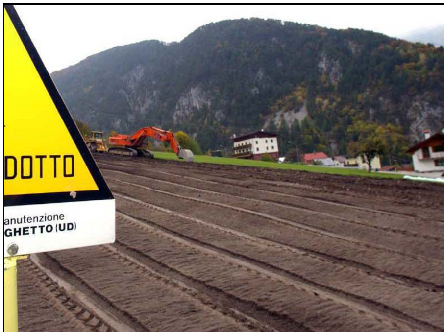
Foto 3.2/F: Distribuzione del topsoil sulla pista di lavoro
