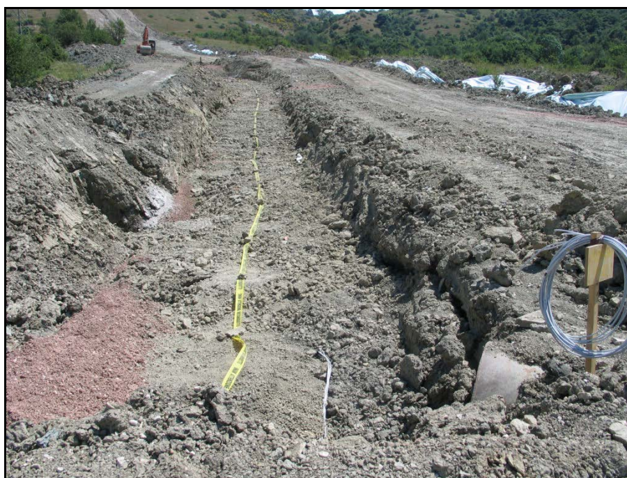
Foto 3.2/E: rinterro della condotta
