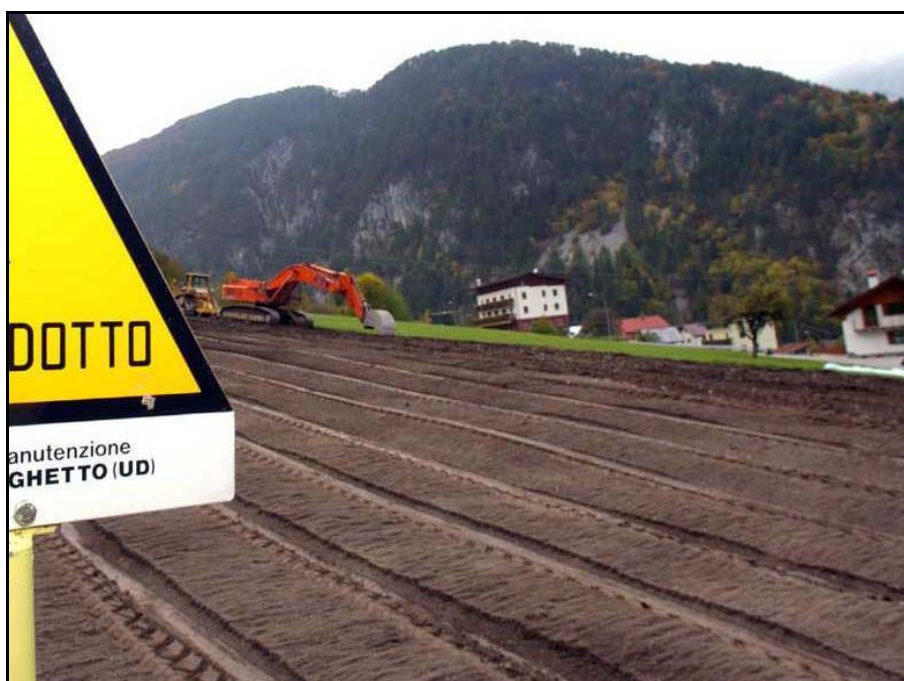
Foto 3.1.F: Distribuzione del topsoil sulla pista di lavoro
