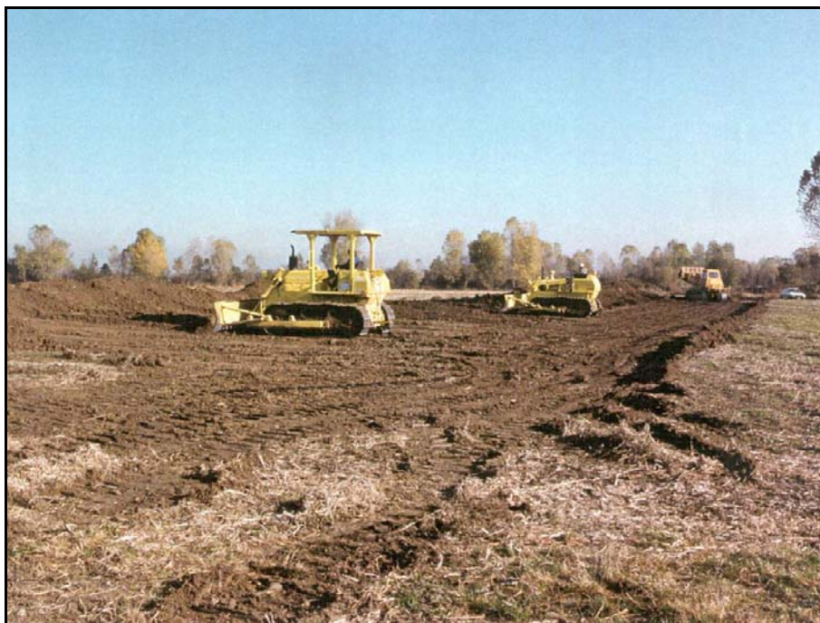
Foto 3.1.B: Apertura della pista di lavoro/passaggio
