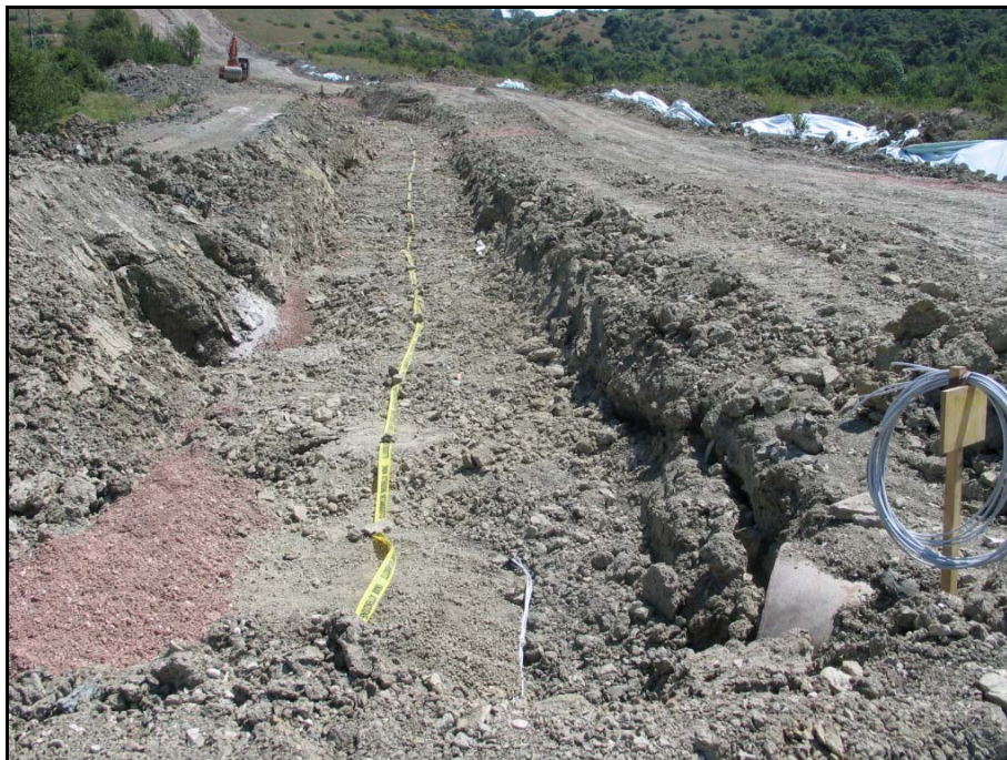
Foto 3.1.E: Rinterro della condotta
