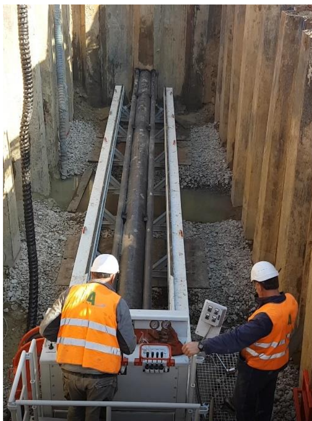
Fig. 7.1.10-A – Esecuzione di trivellazione spingitubo
