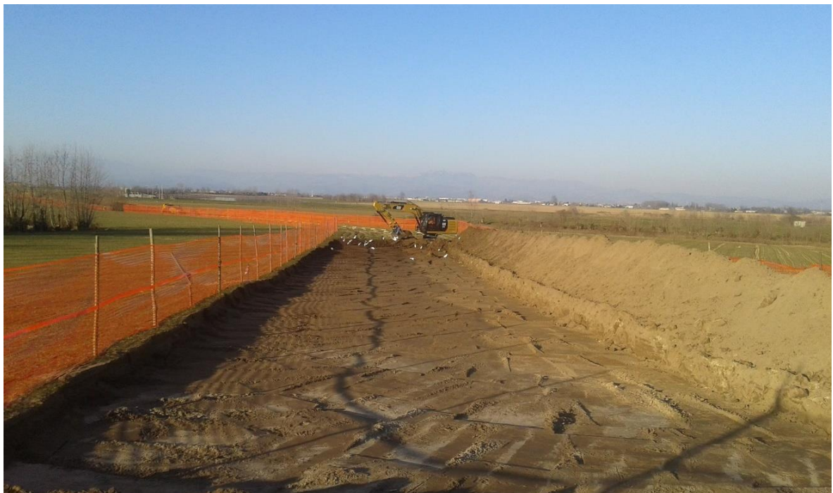
Fig. 7.1.2-A – Foto di apertura della pista di lavoro
