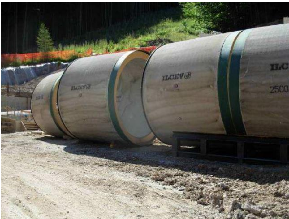
Fig. 7.1.10-H – Stoccaggio tubi in c.a.
