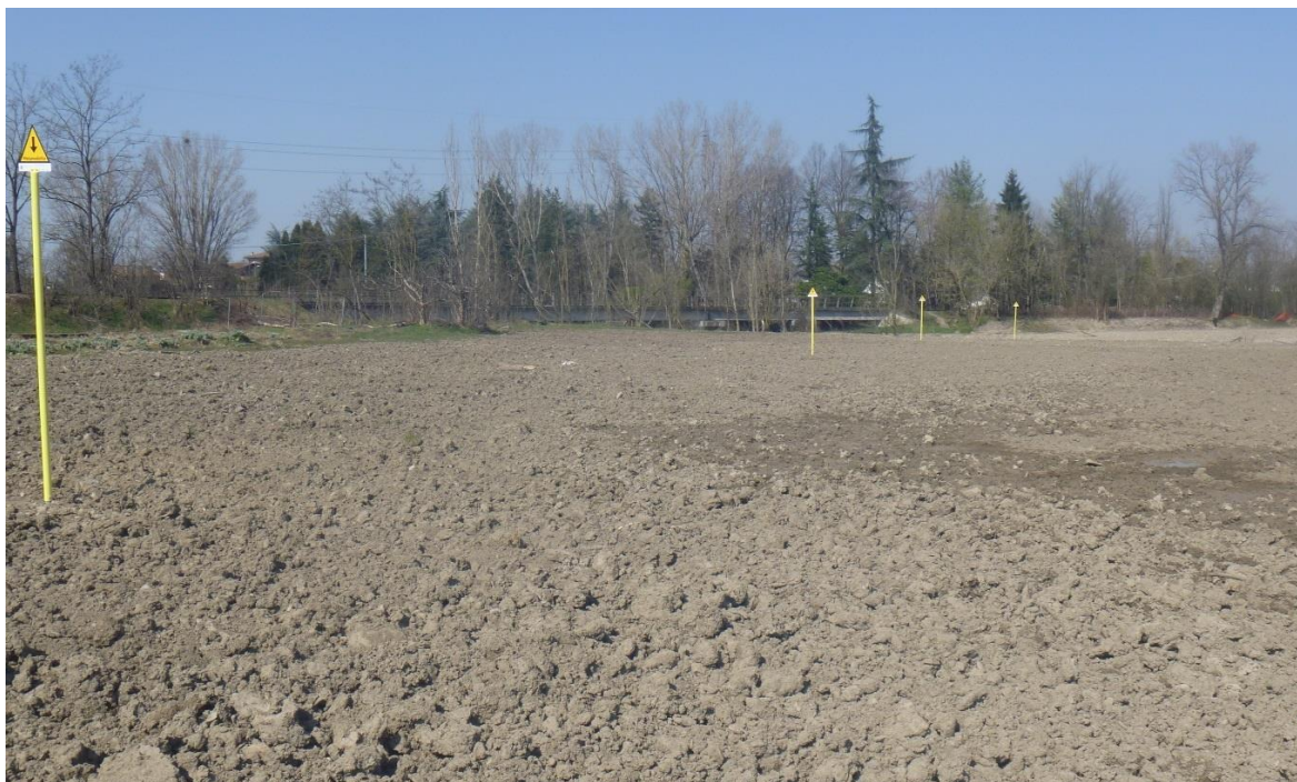
Fig. 7.1.13-A – Pista lavori a ripristini ultimati su un gasdotto in esercizio
