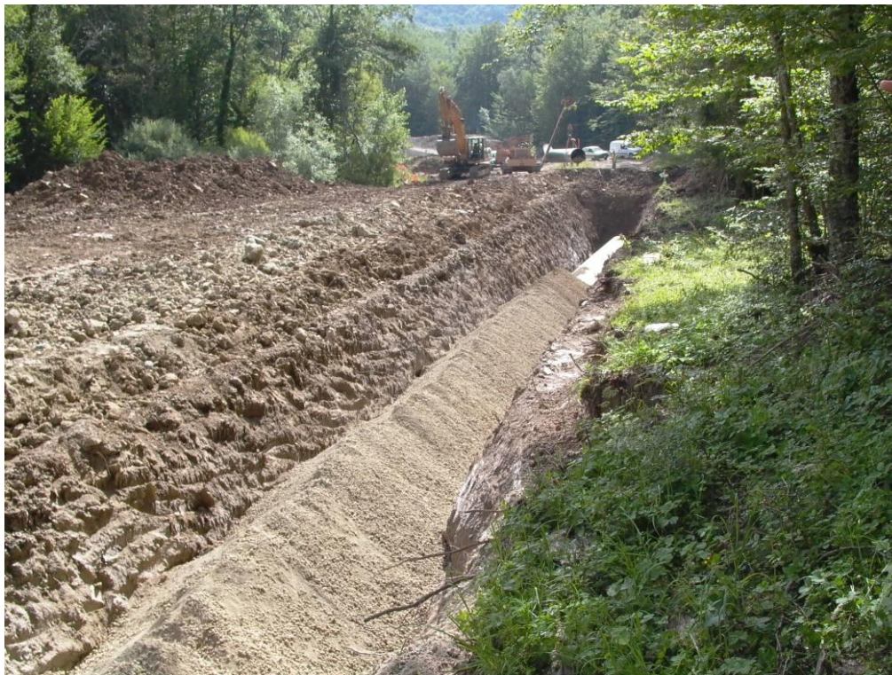
Fig. 7.1.8-B – Rinterro della condotta
