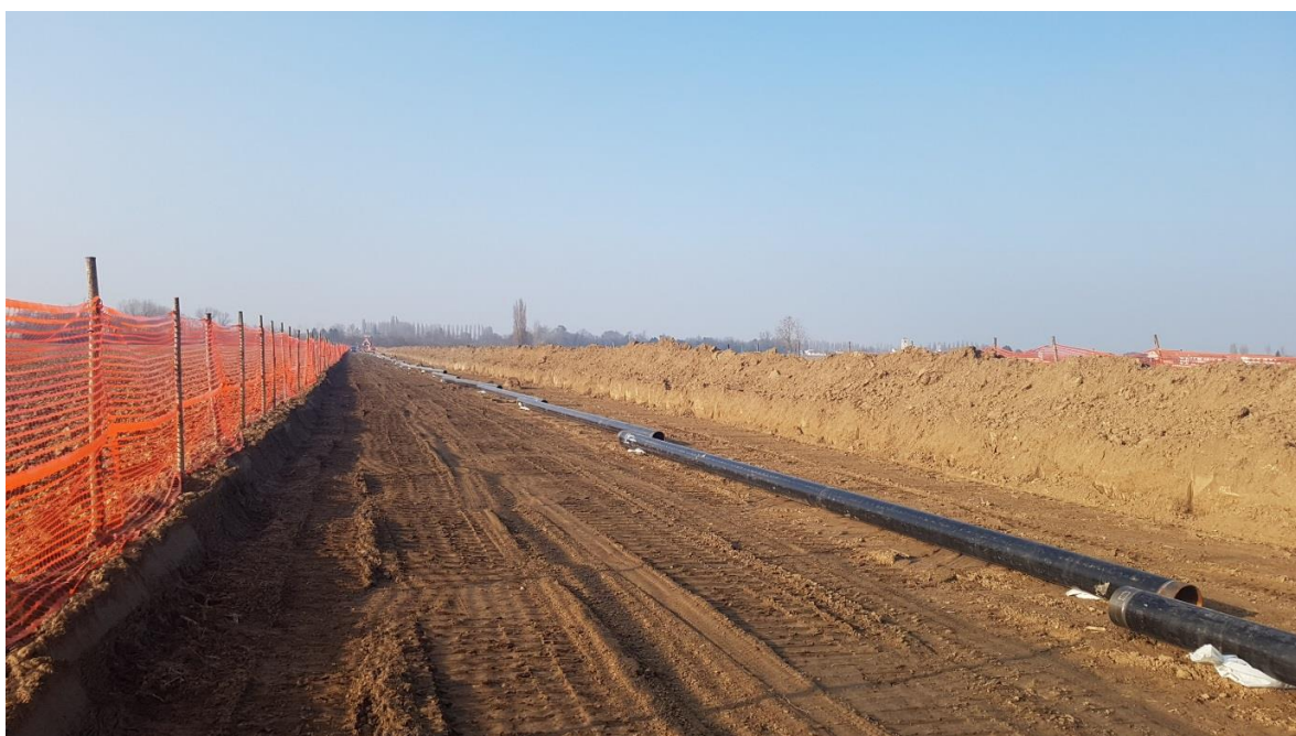
Fig. 7.1.4-A – Sfilamento tubazioni
