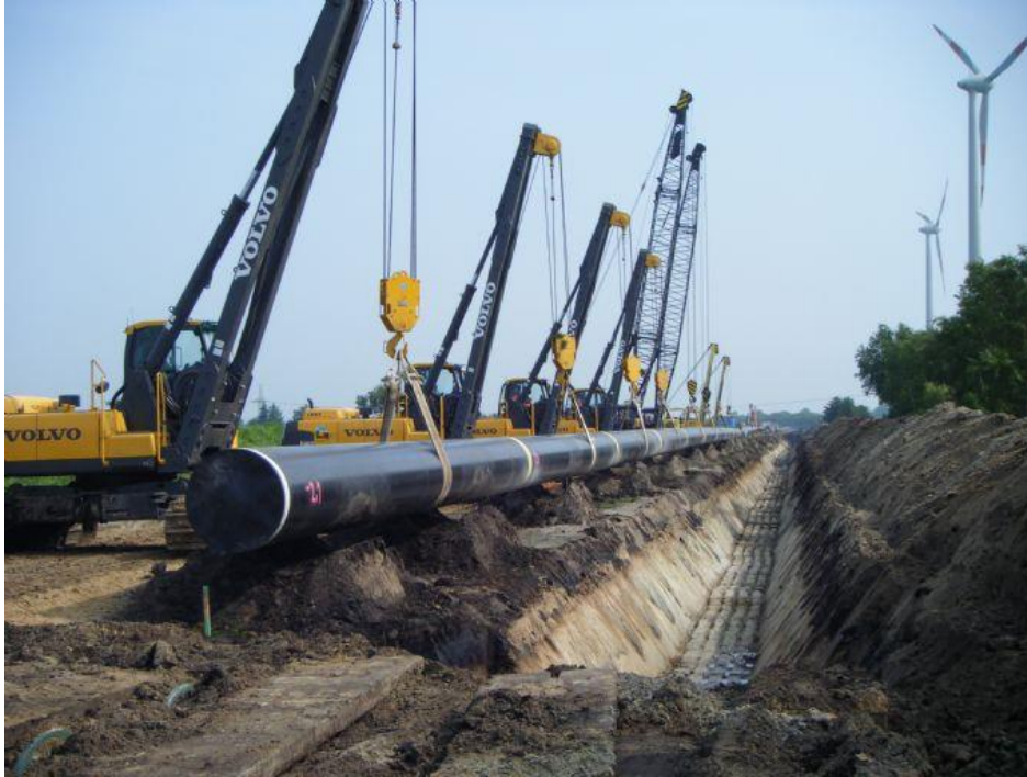
Fig. 7.1.8-A – Posa della condotta
