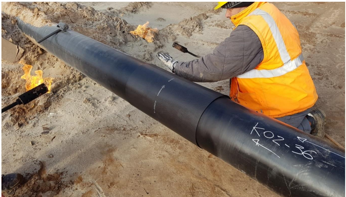
Fig. 7.1.7-A – Applicazione fascia termorestringente su giunto di saldatura
