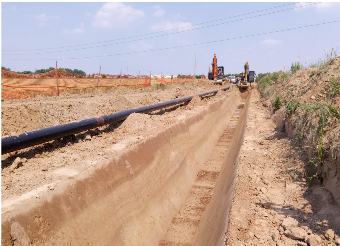
Fig. 7.1.6-A – Foto tipica di scavo della trincea
