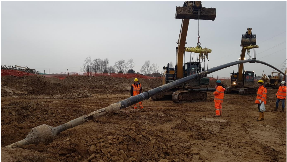
Fig. 7.1.10-C – Operazione di varo della TOC
