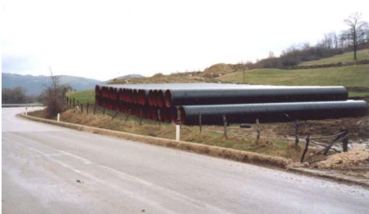
Fig. 7.1.1-A – Foto tipica di una piazzola per accatastamento tubazioni
