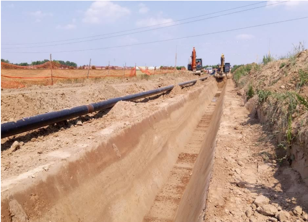
Figura 2-8: Foto tipica di scavo della trincea
