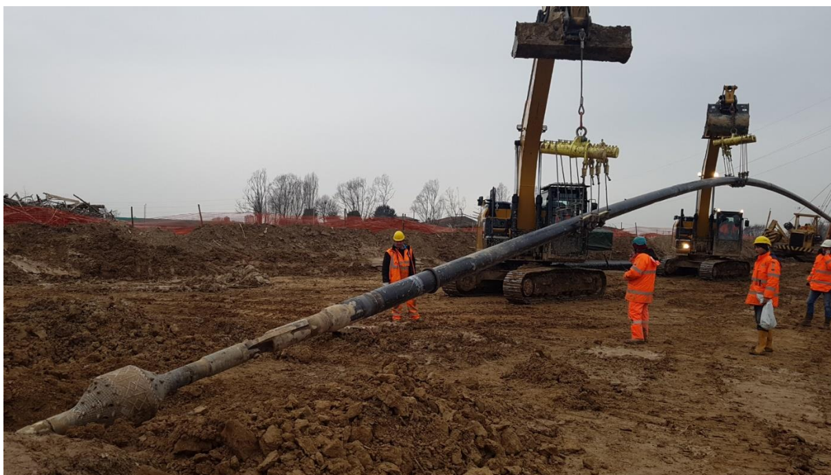
Figura 2-18 – Esempio di operazione di varo della TOC
