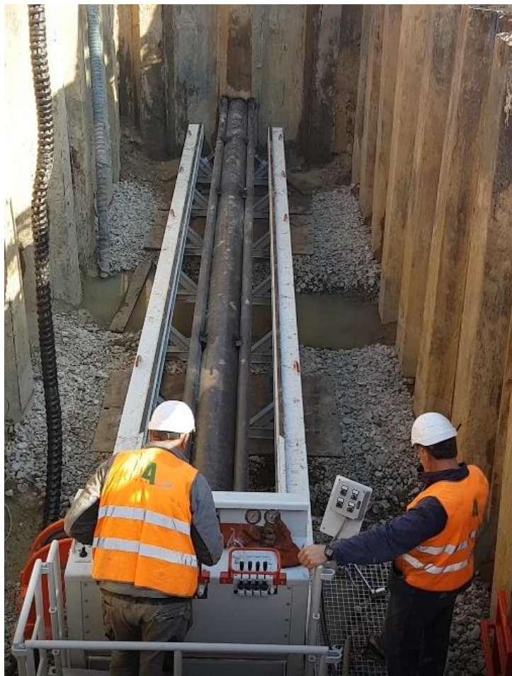
Figura 2-14 – Esecuzione di trivellazione spingitubo
