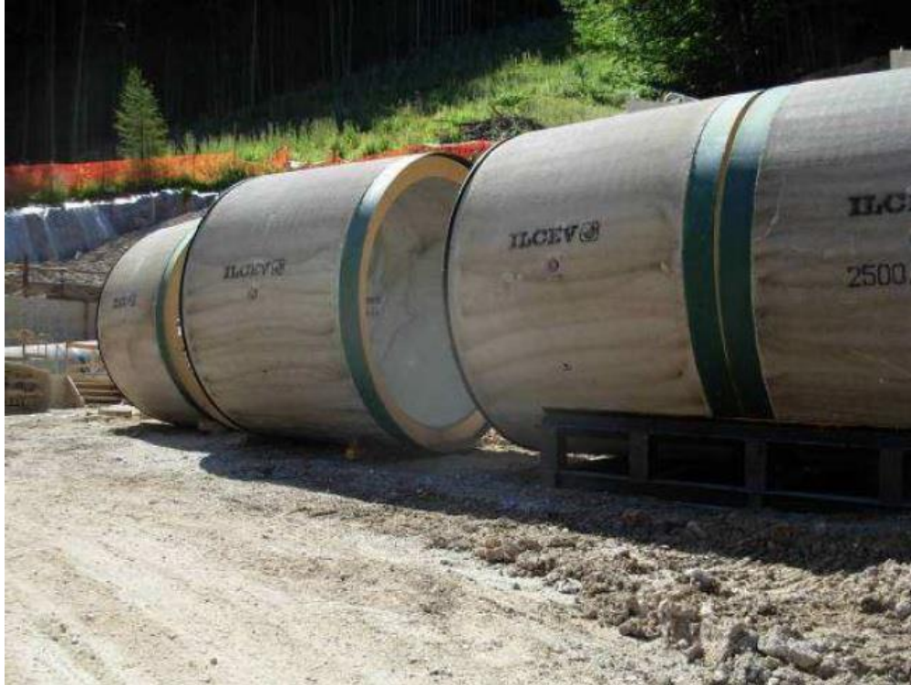
Figura 2-23 – Stoccaggio tubi in c.a.
