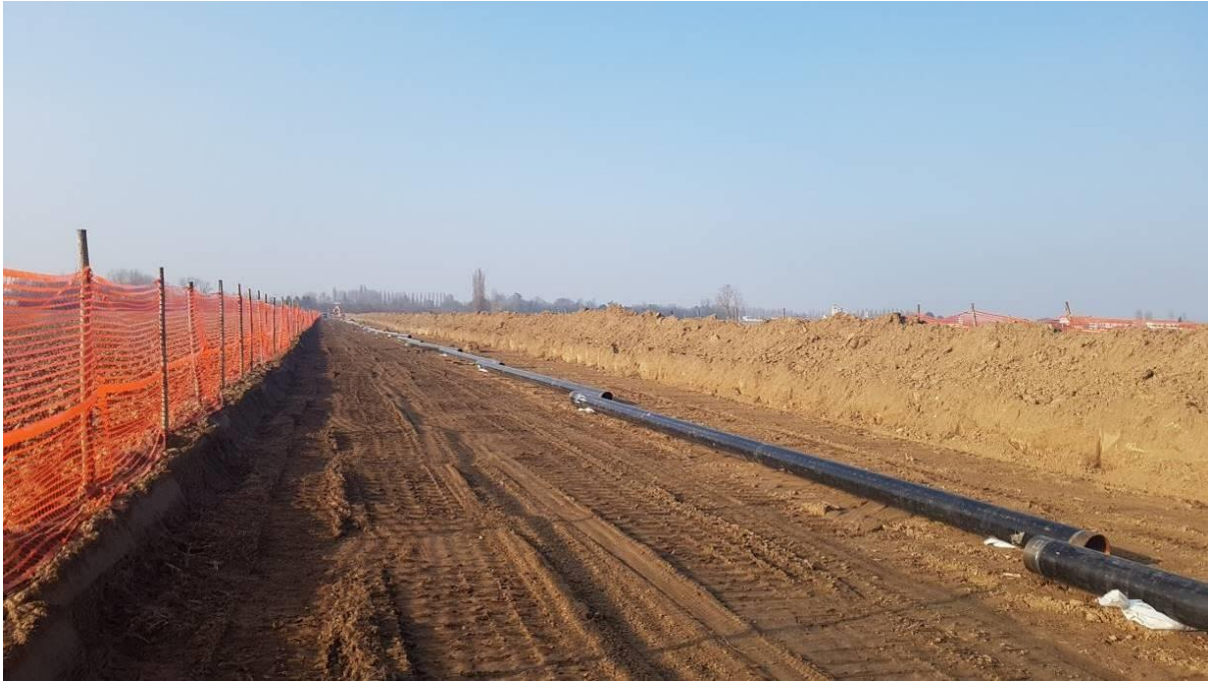
Figura 2-7: Sfilamento tubazioni
