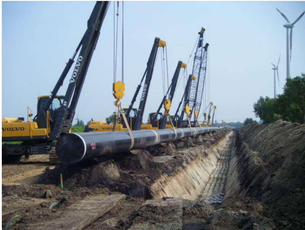
Figura 2-9: Posa della condotta
