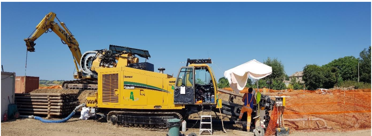
Figura 2-17 – Esempio di Rig
