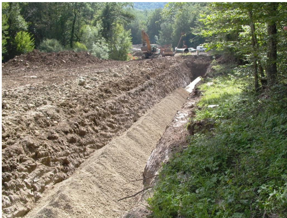
Figura 2-10: Rinterro della condotta
