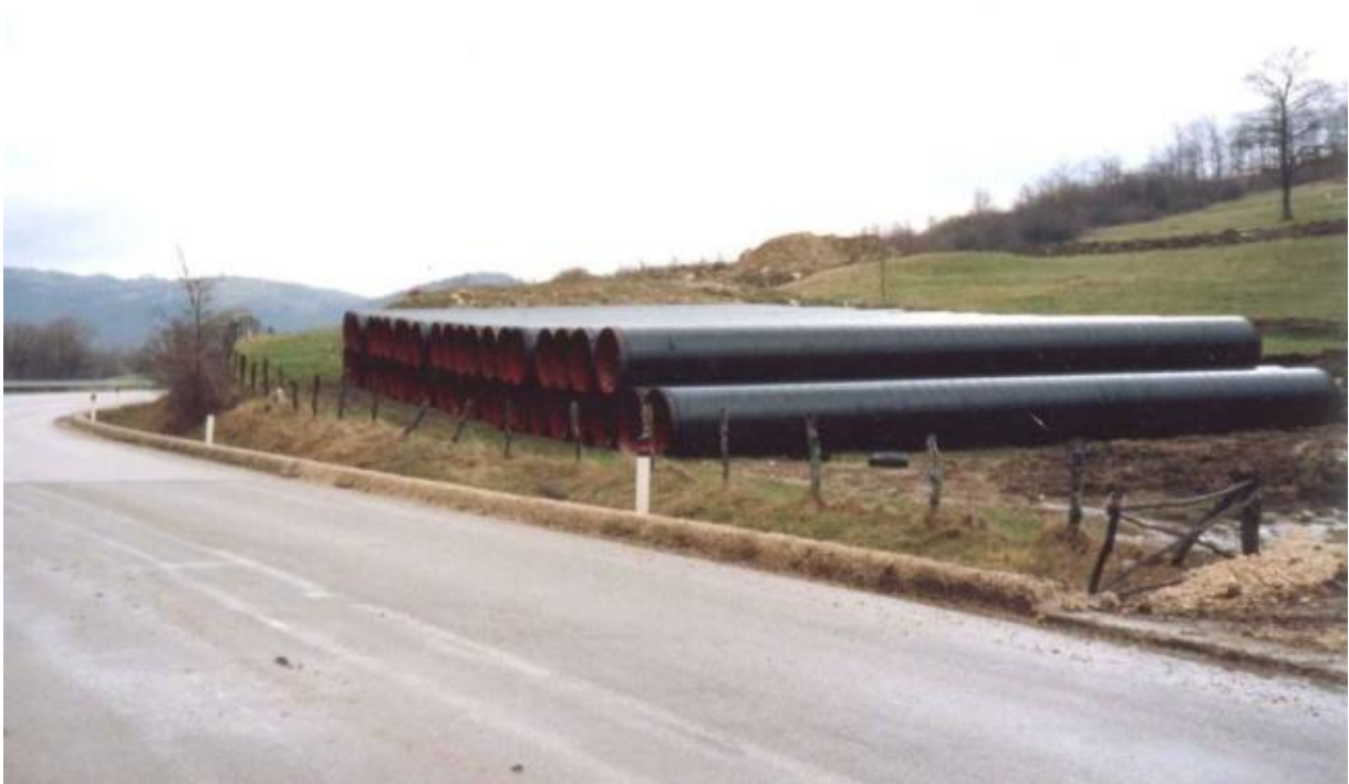
Figura 2-3: Foto tipica di una piazzola per accatastamento tubazioni
