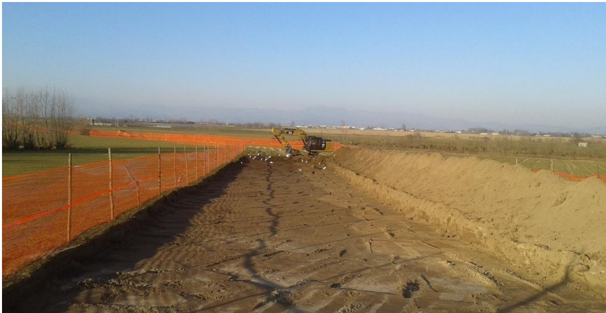
Figura 2-4: Foto di apertura della pista di lavoro
