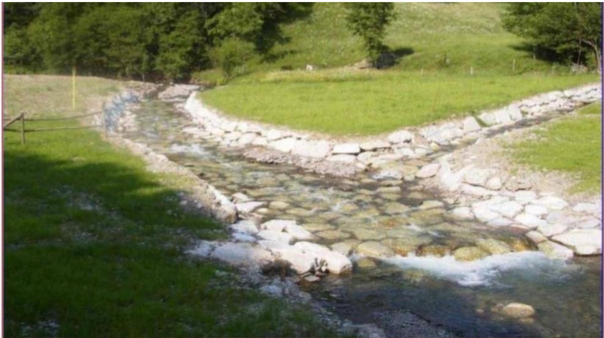
**Figura 9-3 – Esempio di rivestimento in massi e platea di fondo**
