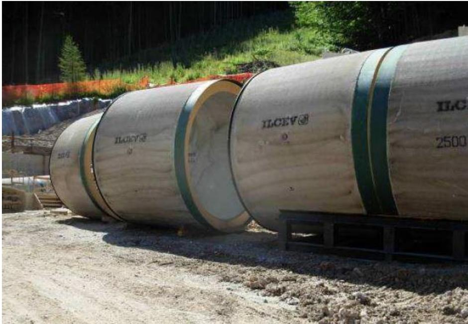
**Figura 8-8 - Stoccaggio tubi in c.a.**
