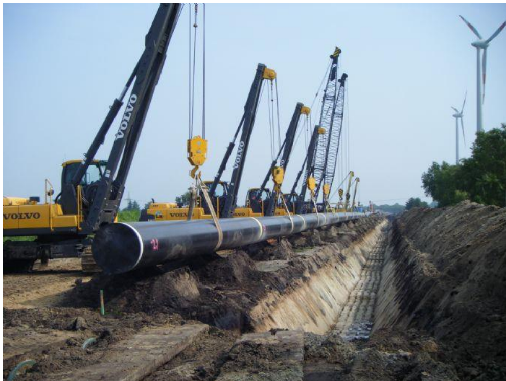
Fig. 2.5.4-A – Posa della condotta
