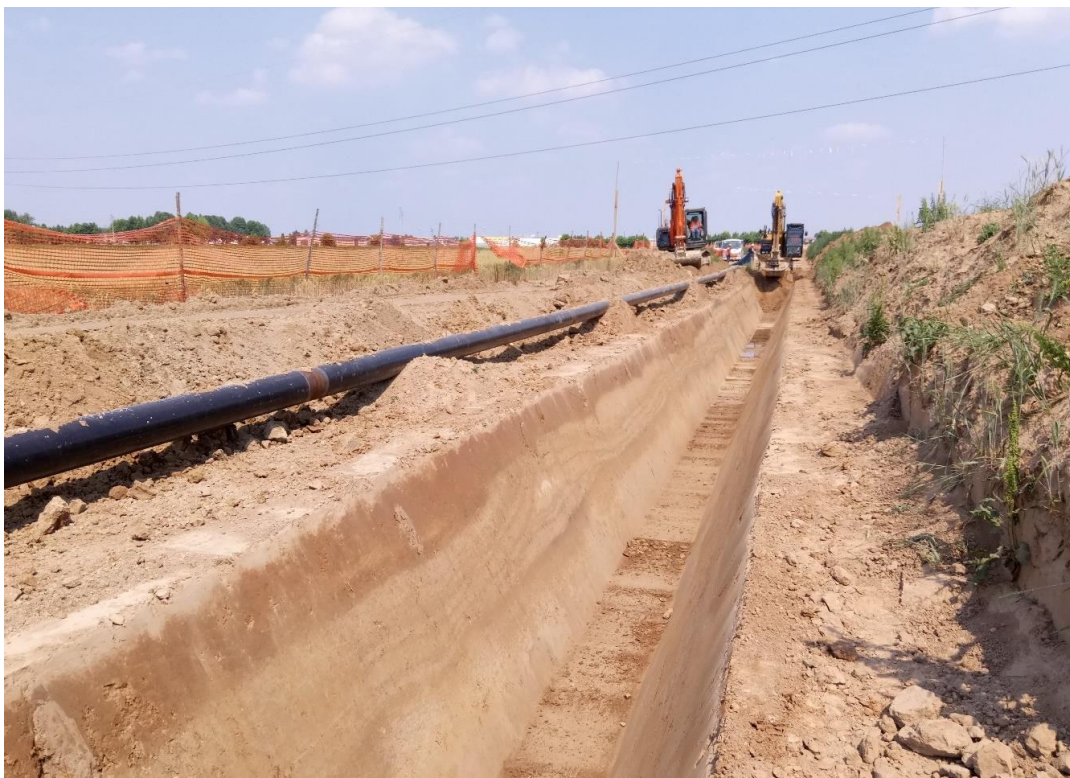
Fig. 2.5.3-A – Foto tipica di scavo della trincea
