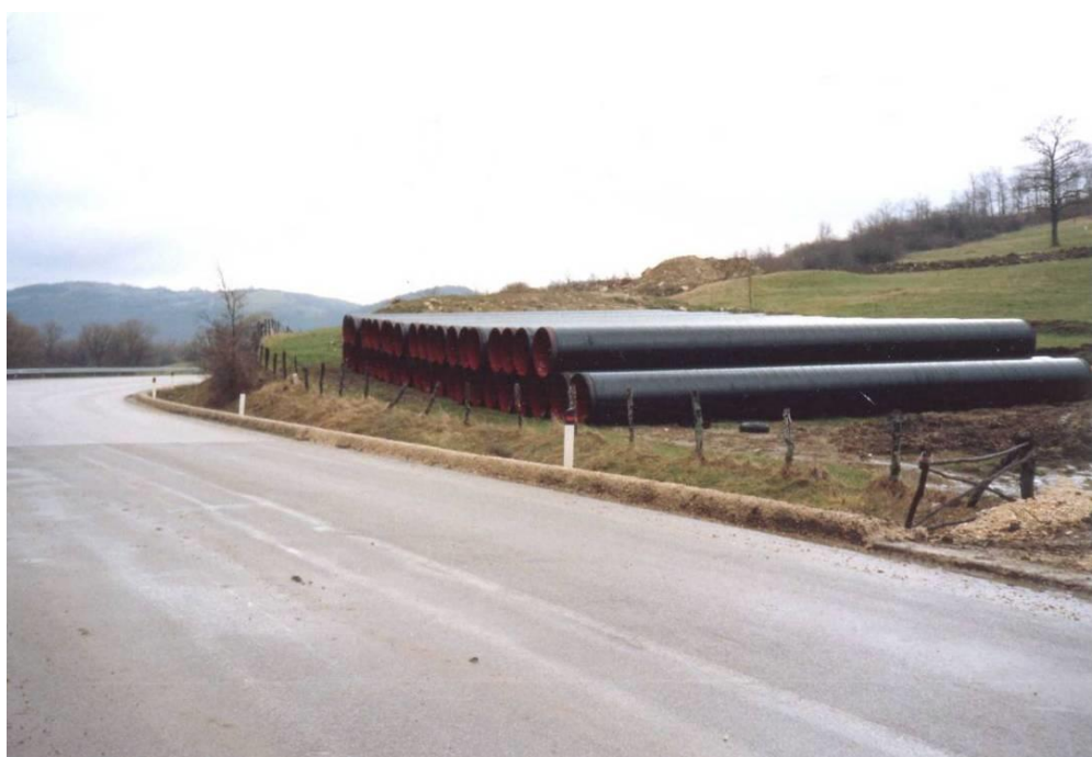
Fig. 2.5.1-A – Foto tipica di una piazzola per accatastamento tubazioni
