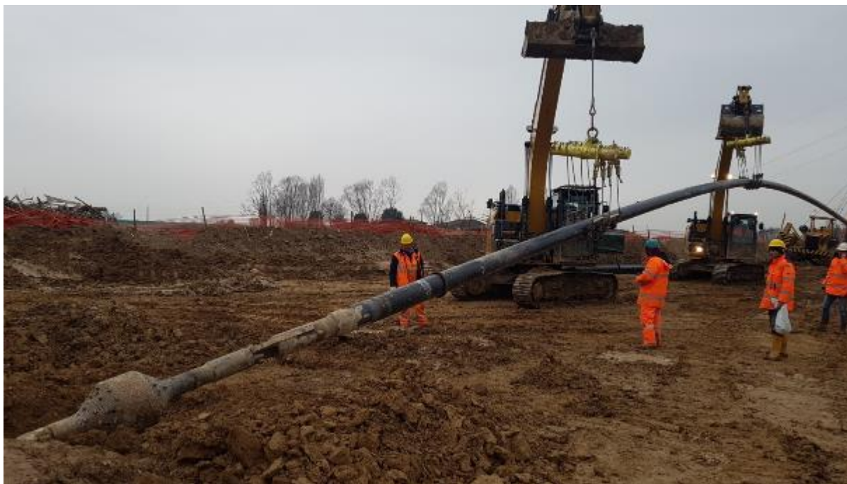
Figura 3-27 – Esempio di operazione di varo della TOC
