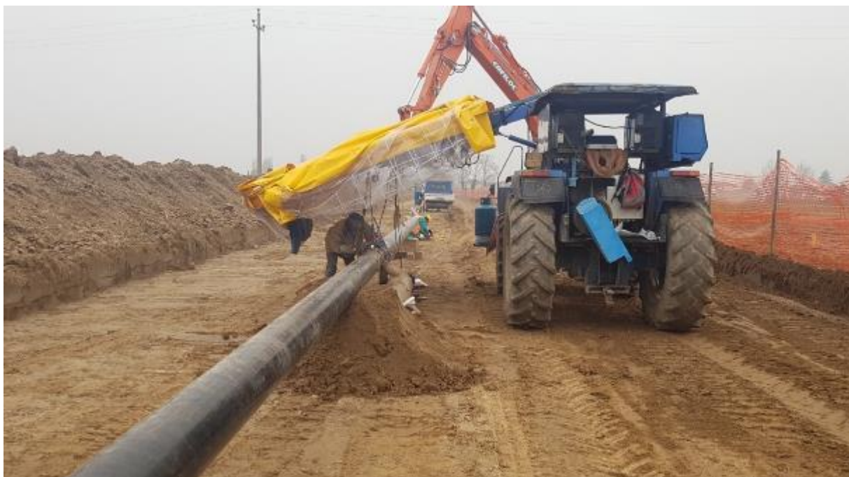
Figura 3-14 – Fase di saldatura manuale
