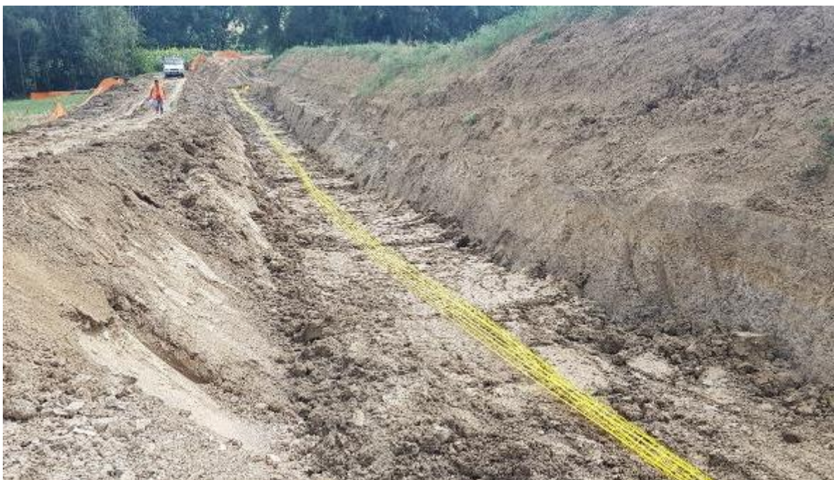
Figura 3-19 – Rinterro della condotta
