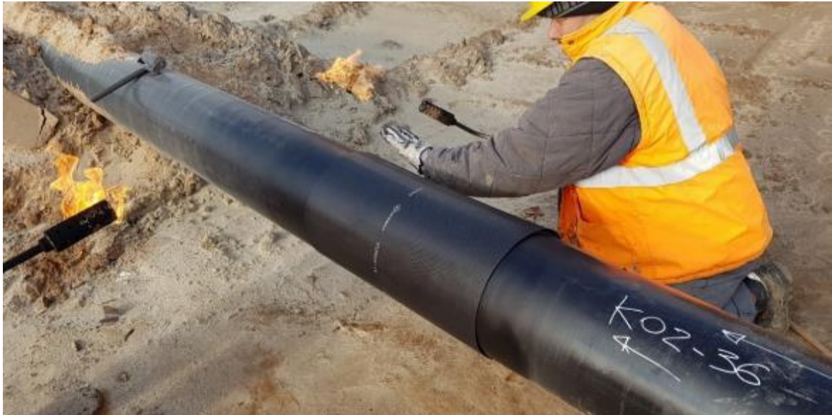
Figura 3-17 – Applicazione manuale di una fascia termorestringente su giunto di saldatura
