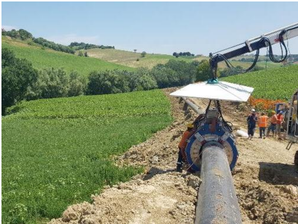
Figura 3-15 – Esempio di saldatura automatica
