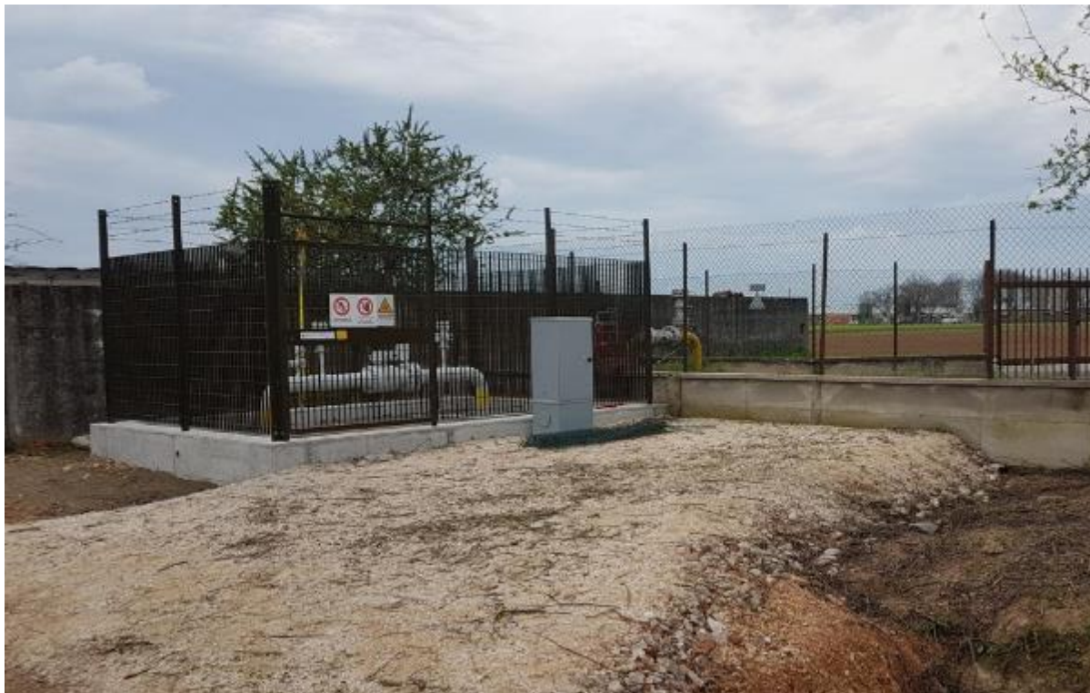
Figura 3-33 – Esempio di impianto al termine dei lavori
