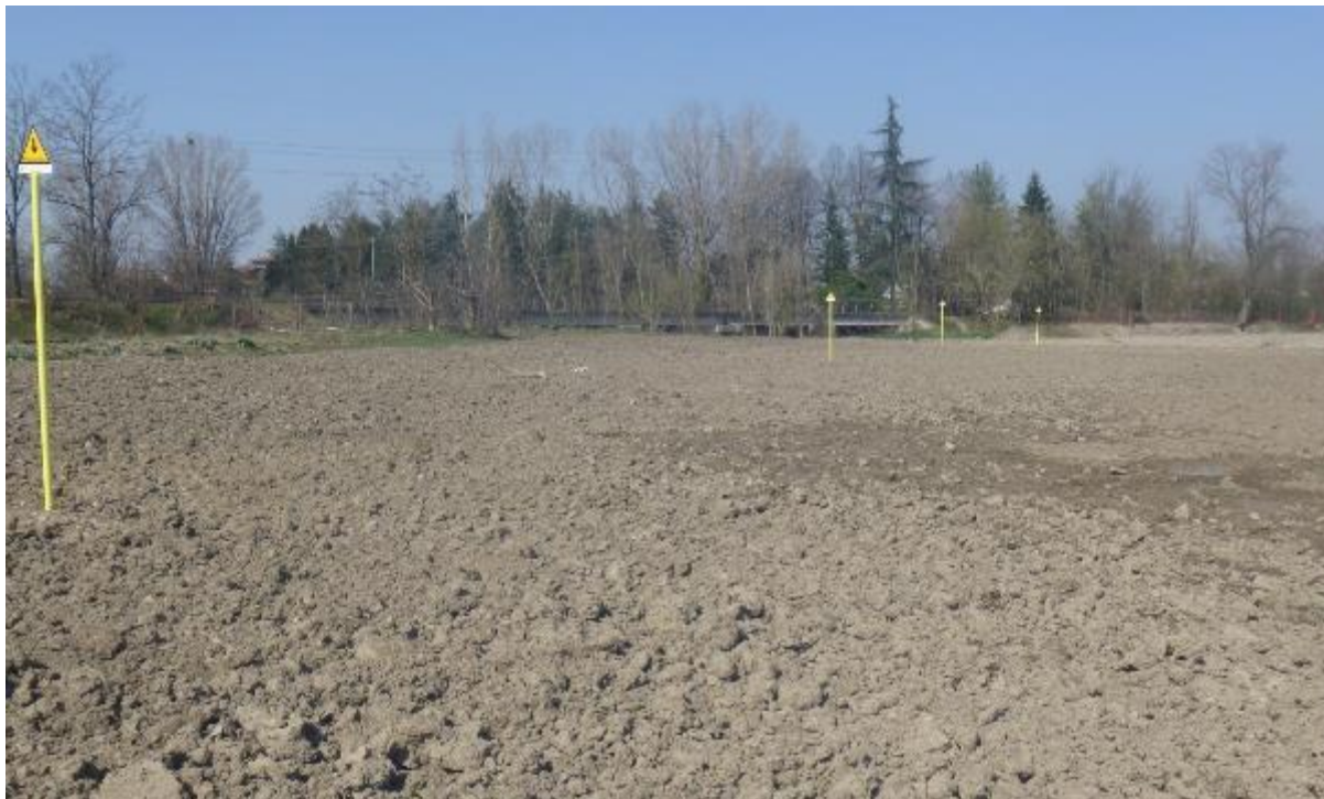
Figura 3-34 – Pista lavori, su terreno agricolo, a ripristini ultimati; si nota la disposizione delle paline segnaletiche su metanodotto in esercizio
