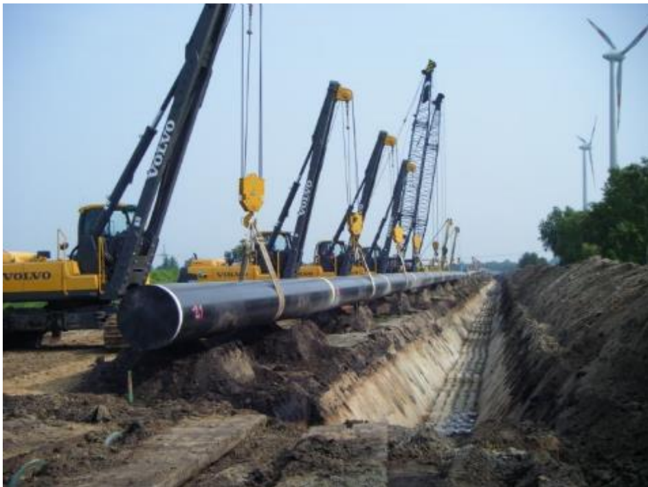
Figura 3-18 – Posa della condotta
