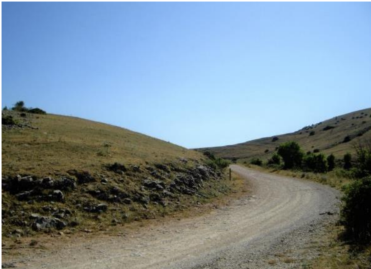
Figura 5-41 - Formazioni erbacee a pascolo poste lungo il tracciato in rifacimento al km 47 circa
