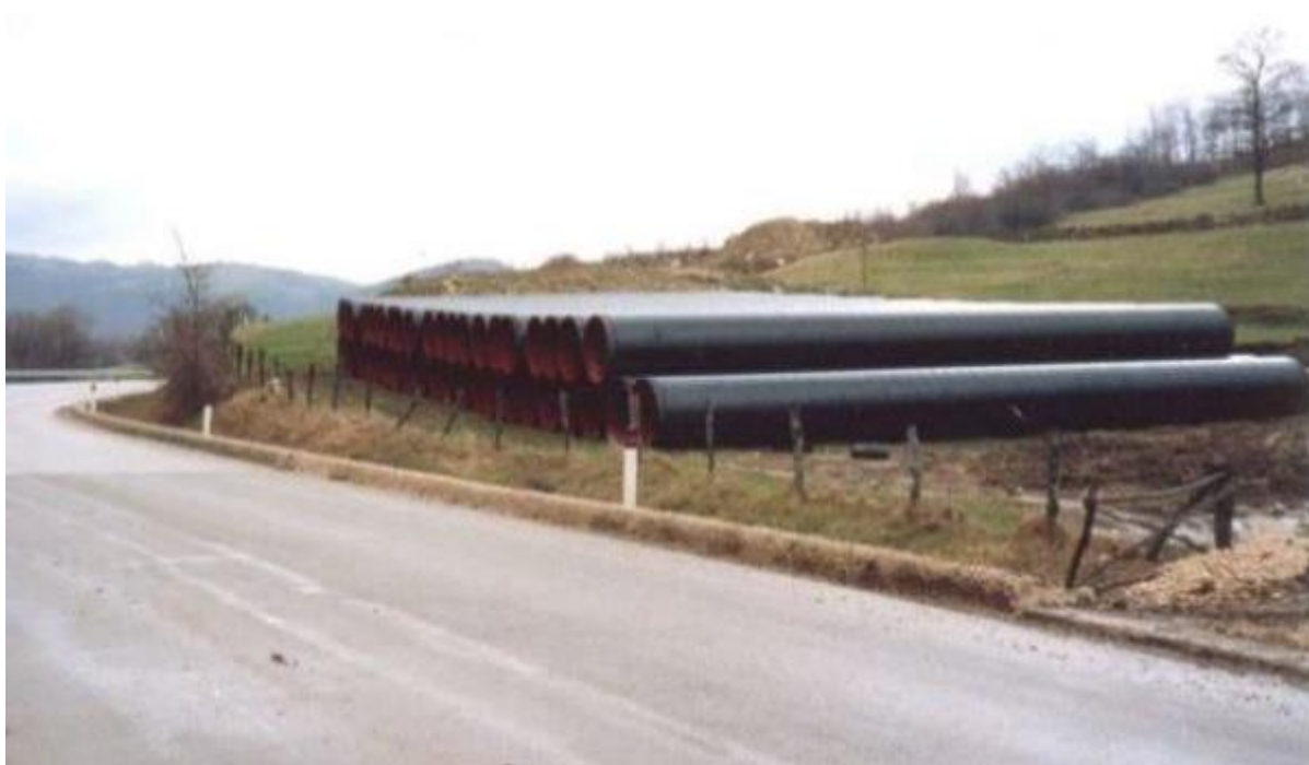
Figura 3-9 – Piazzola di accatastamento tubazioni
