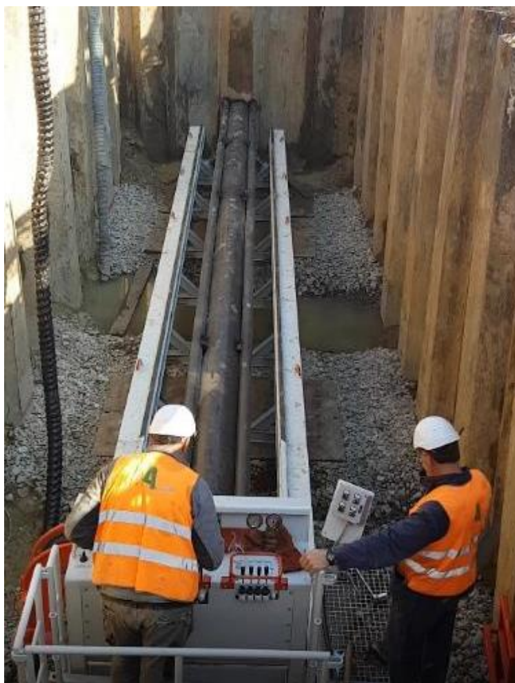
Figura 3-23 – Esecuzione di trivellazione spingitubo
