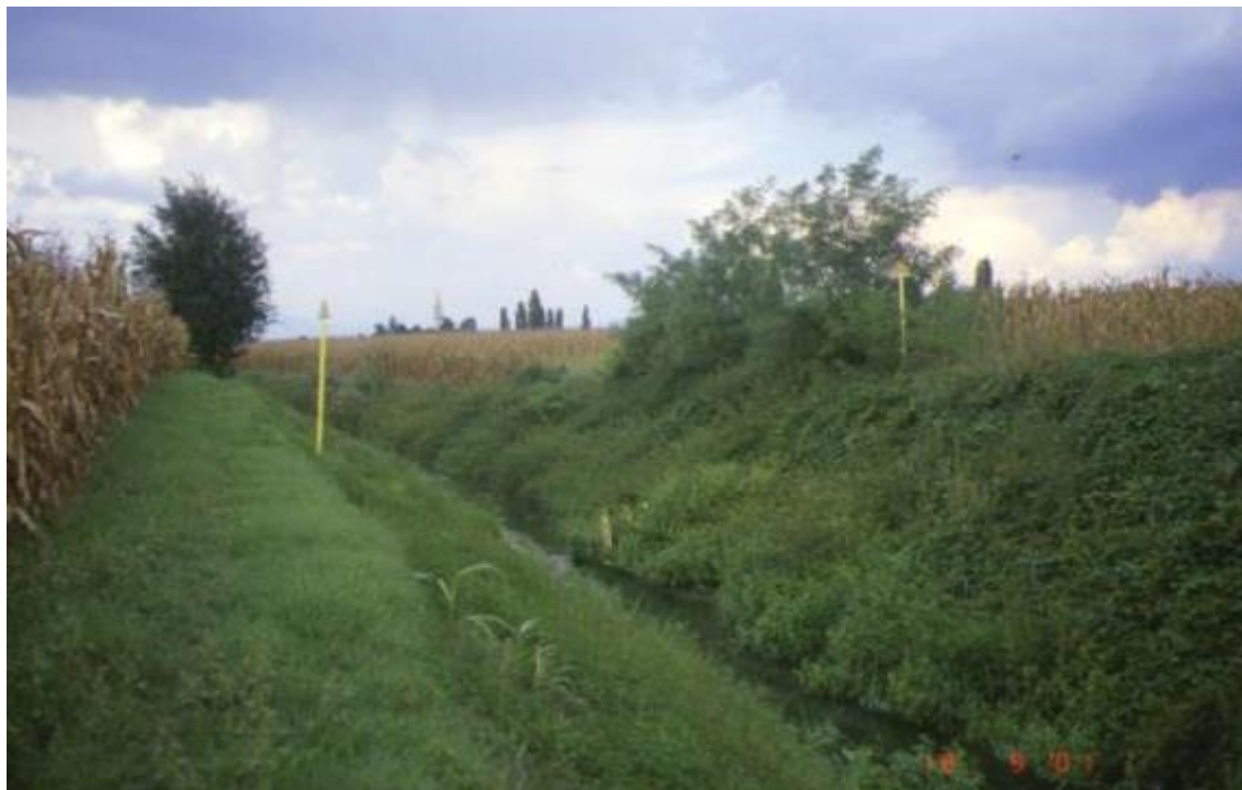
Figura 3-44 – Esempio di opera ultimata in corrispondenza di attraversamento di corso d'acqua in ambito agricolo
