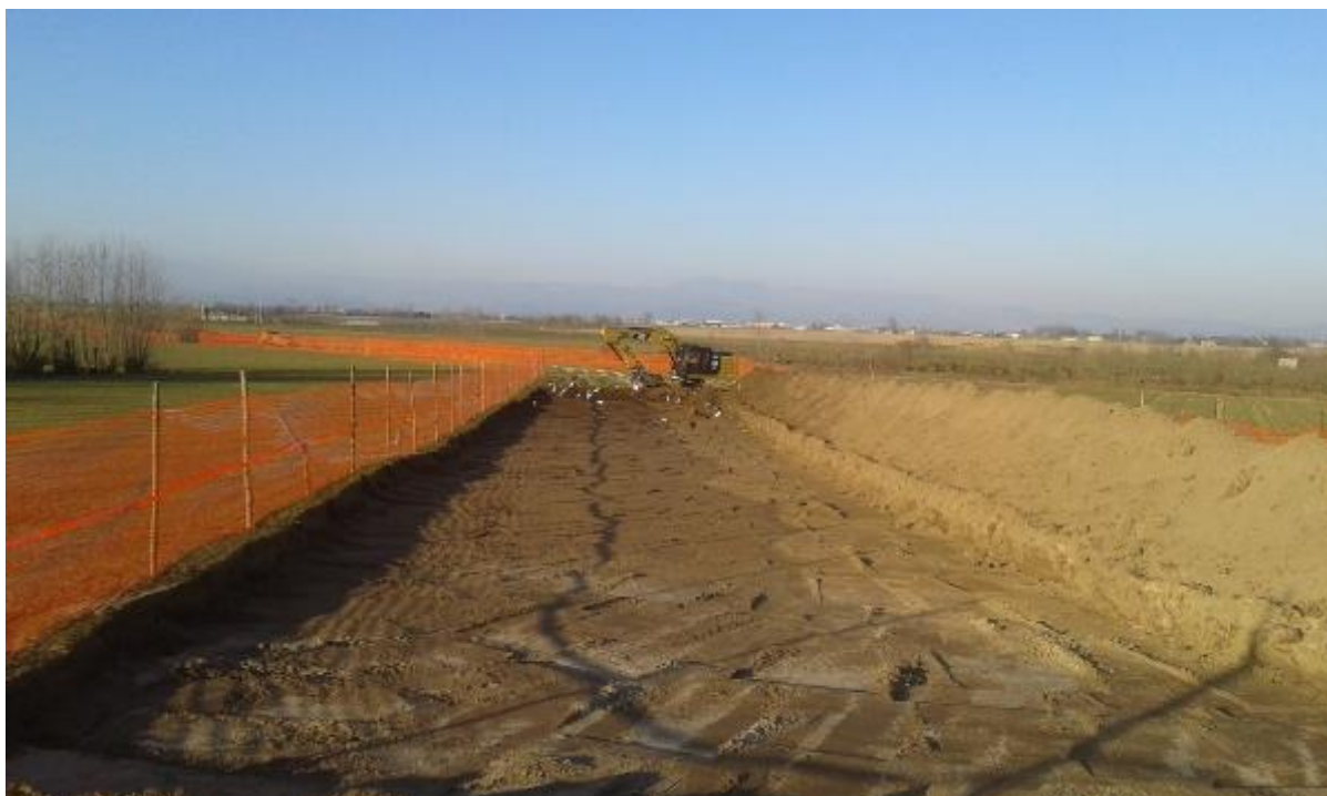
Figura 3-10 – Foto di apertura della pista di lavoro
