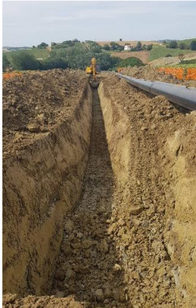
Figura 3-16 – Scavo della trincea
