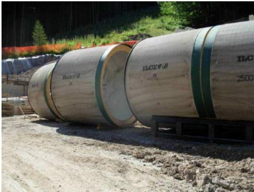
Figura 3-32 – Stoccaggio tubi in c.a.
