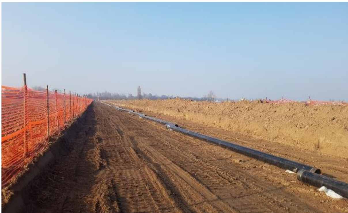
Figura 3-13 – Sfilamento delle tubazioni di linea
