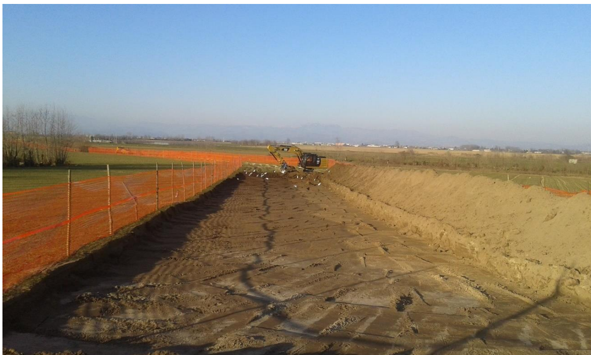
Figura 5.1-2 – Foto di apertura della pista di lavoro
