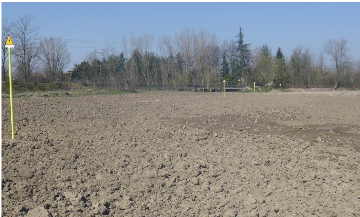
Figura 5.1-12 – Fascia di lavoro ad opera ultimata su un gasdotto in esercizio
