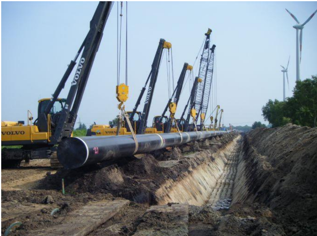
Figura 5.1-8 – Foto di posa della condotta
