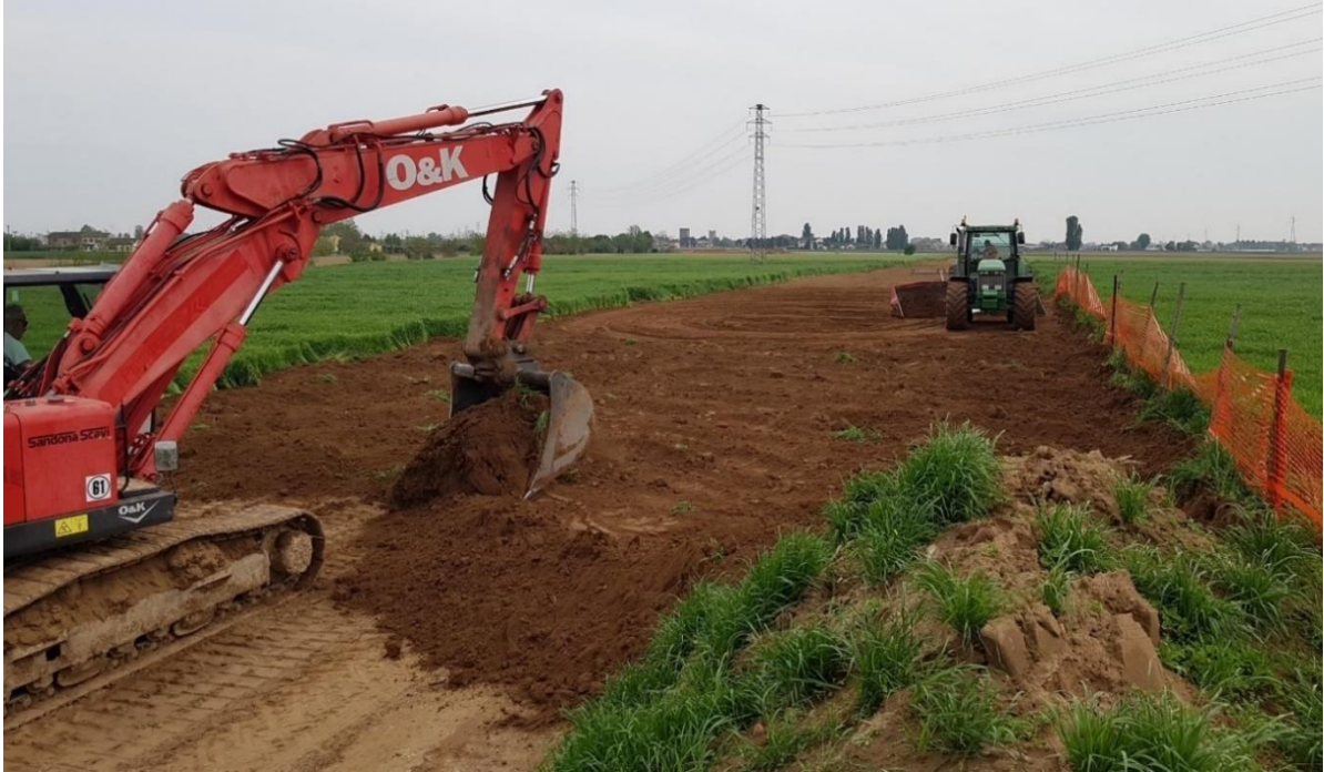
Figura 5.1-11 – Foto del ripristino del terreno superficiale e suo livellamento
