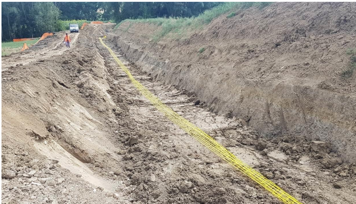
Figura 5.1-9 – Foto di rinterro della condotta
