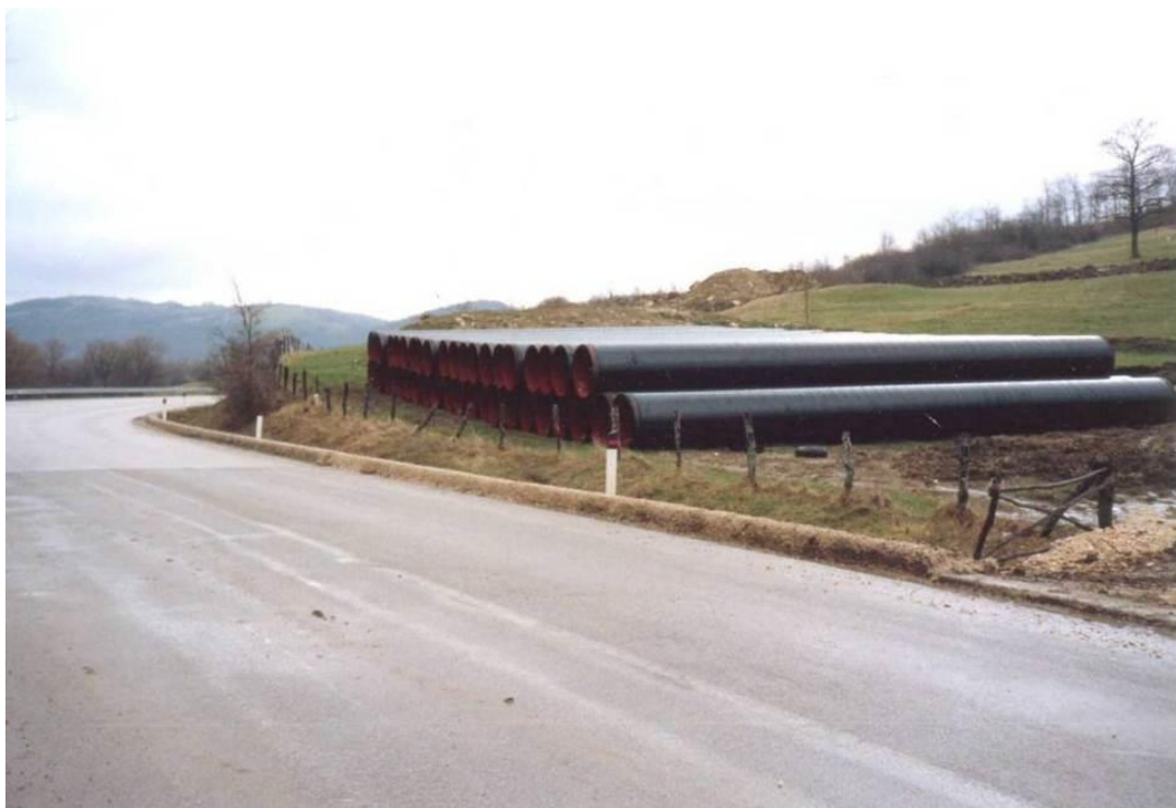
Figura 5.1-1 – Foto tipica di una piazzola per accatastamento tubazioni
