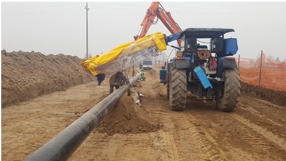
Figura 5.1-6 – Foto di saldatura manuale
