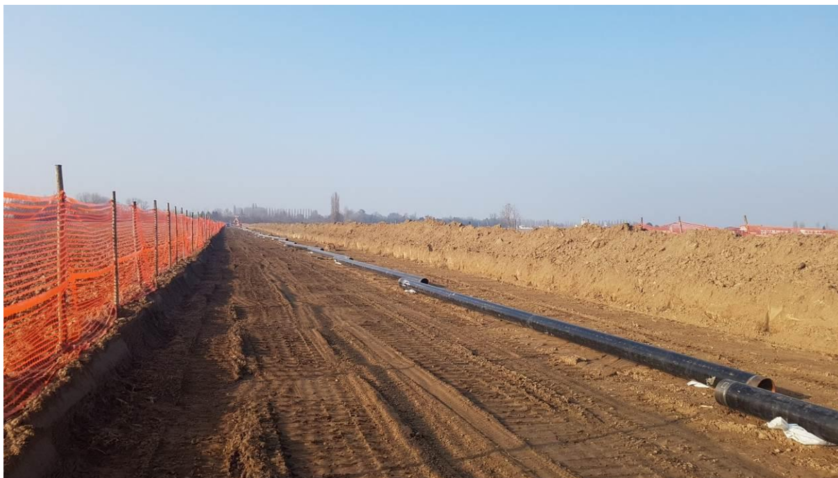
Figura 5.1-5 – Foto di sfilamento delle tubazioni
