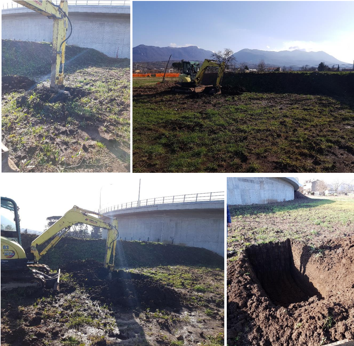
Realizzazione trincea: punto di monitoraggio SUO-01
