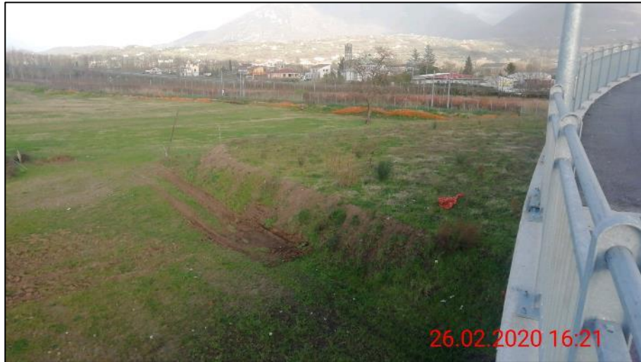
FIGURA 5 – OPERA A VERDE CAVALCAVIA VERSANTE FERROVIA
