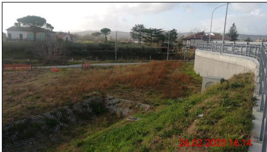
FIGURA 9 – VISTA RAMPA INGRESSO ROTATORIA
