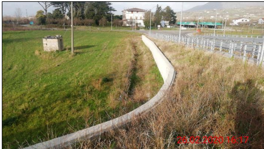
FIGURA 12 –RAMPA INGRESSO LATO S.P.111
