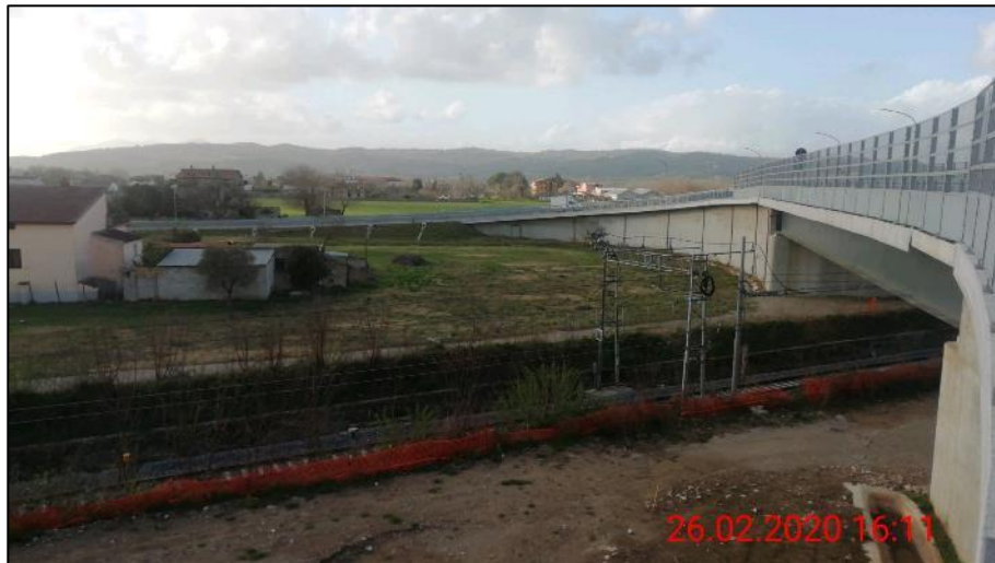
FIGURA 6 – CAVALCAVIA SOVRAPPASSO FERROVIA
