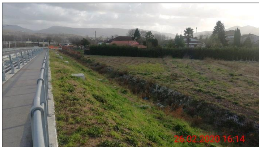
FIGURA 8 – VISTA RAMPA ACCESSO S.P. 50
