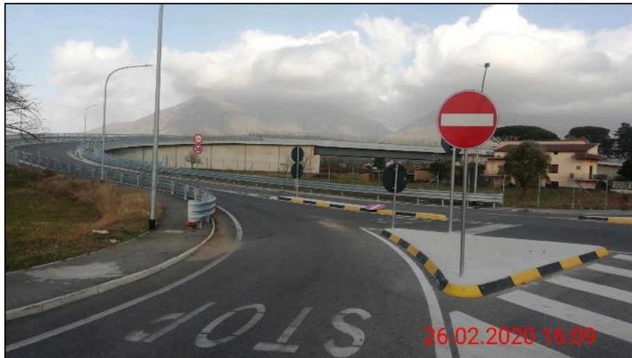
FIGURA 2 – INGRESSO CAVALCAVIA VIA CALABRONI
