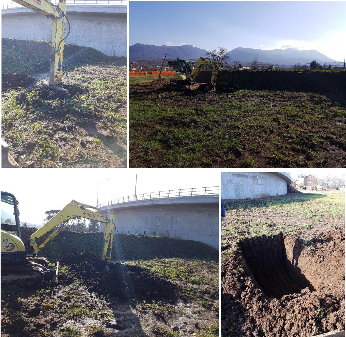
Realizzazione trincea: punto di monitoraggio SUO-01
