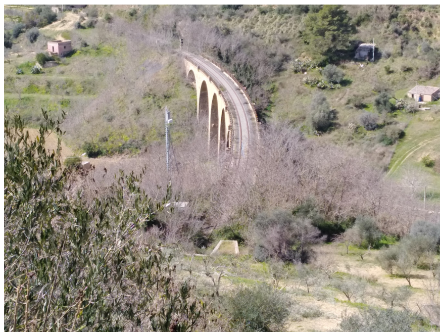
FIGURA 10: VIADOTTO VIADOTTO KM 322+593 – VISTA GENERALE DLL'OPERE.
