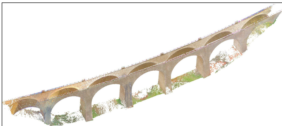
FIGURA 9: VIADOTTO VIADOTTO KM 322+593 – RESTITUZIONE LASERSCANNER DELL'OPERA..
