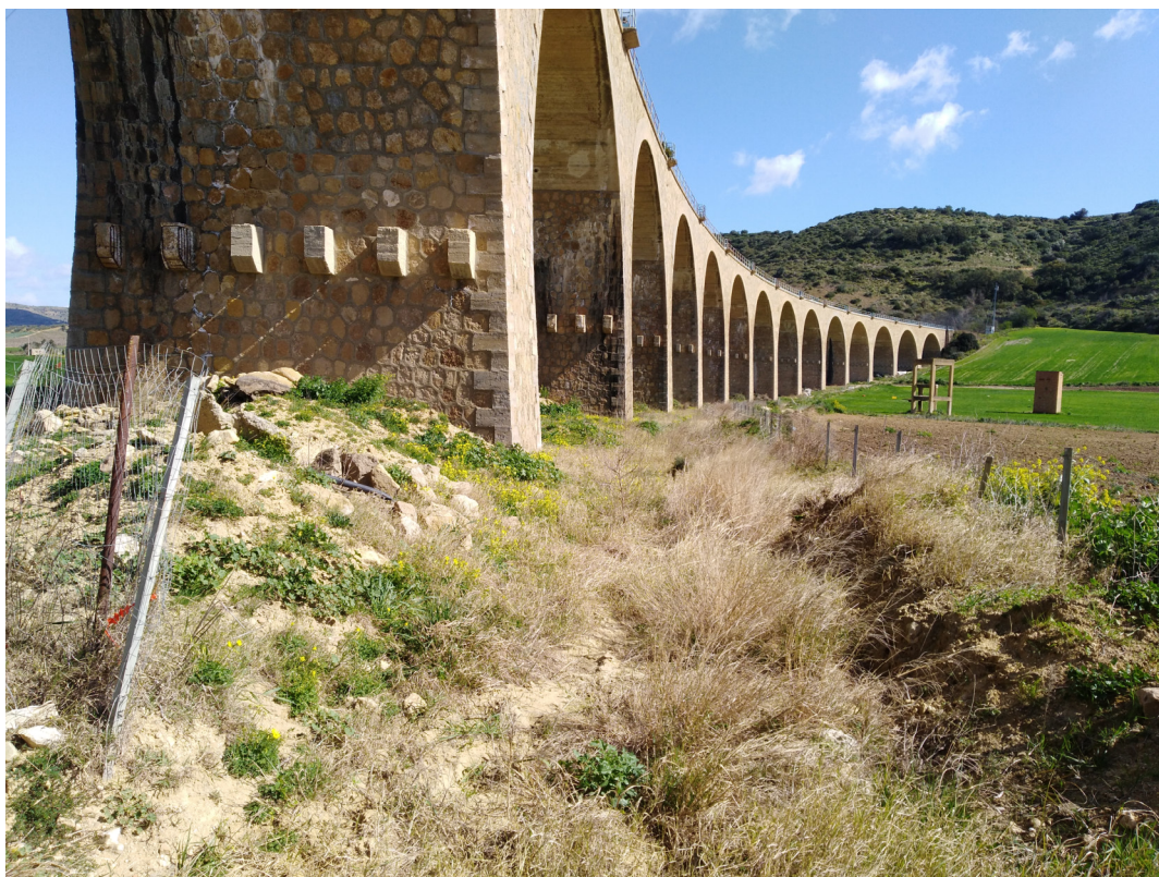
FIGURA 13: VIADOTTO VIADOTTO KM 328+550 – VISTA GENERALE DELL'OPERA
