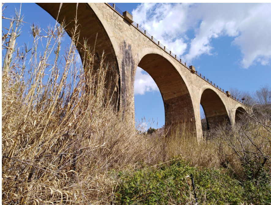
FIGURA 11: VIADOTTO VIADOTTO KM 322+593 – VISTA GENERALE DLL'OPERE.
