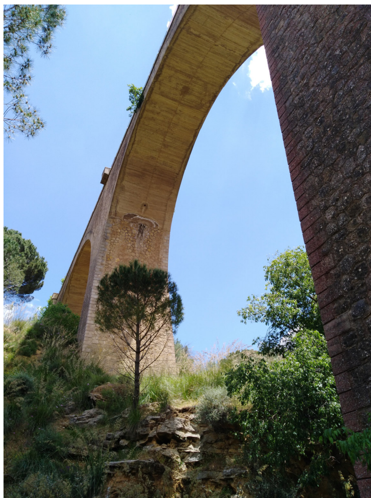
FIGURA 8: VIADOTTO VIADOTTO KM 320+757 – DETTAGLIO ARCATA.
