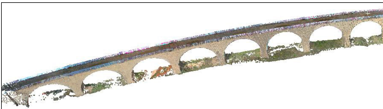
FIGURA 13: VIADOTTO VIADOTTO KM 328+550 – RESTITUZIONE LASERSCANNER DELL'OPERA N.1.
