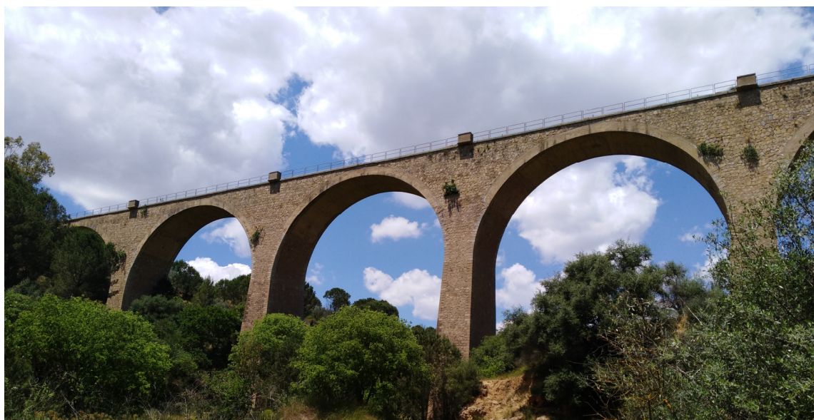
FIGURA 6: VIADOTTO VIADOTTO KM 320+757 – VISTA GENERALE DLL'OPERE.
