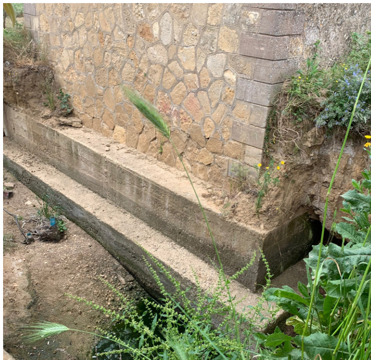
FIGURA 4: VIADOTTO VIADOTTO KM 318+516 - DETTAGLIO FONDAZIONE PILA 5
