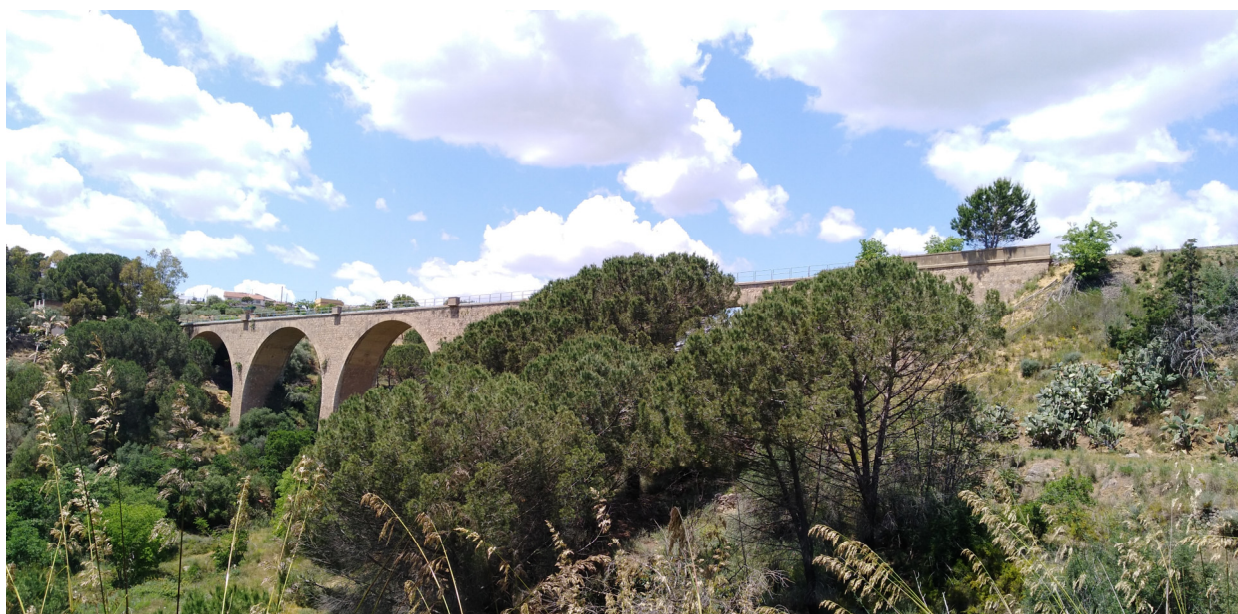
FIGURA 7: VIADOTTO VIADOTTO KM 320+757 – VISTA GENERALE DLL'OPERE.
