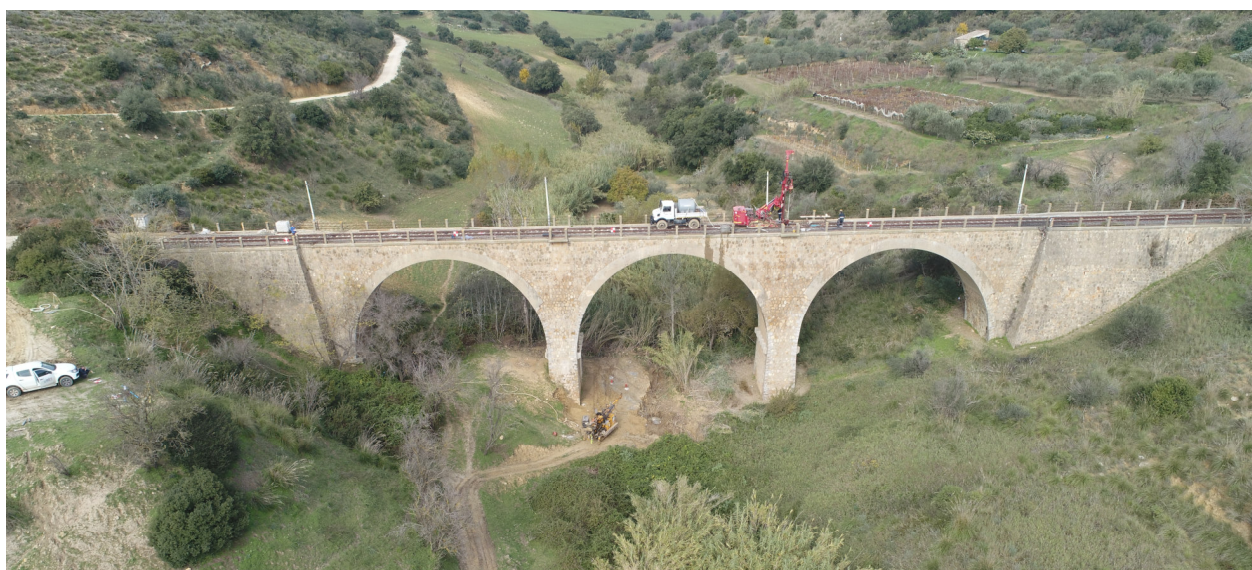
FIGURA 12: VIADOTTO VIADOTTO KM 327+229 – VISTA GENERALE DLL'OPERE.
