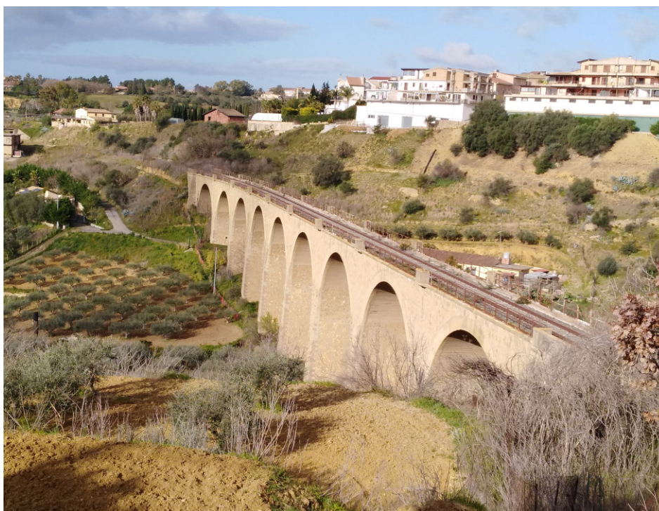
FIGURA 2: VIADOTTO VIADOTTO KM 318+516 - VISTA GENERALE DELL'OPERA
