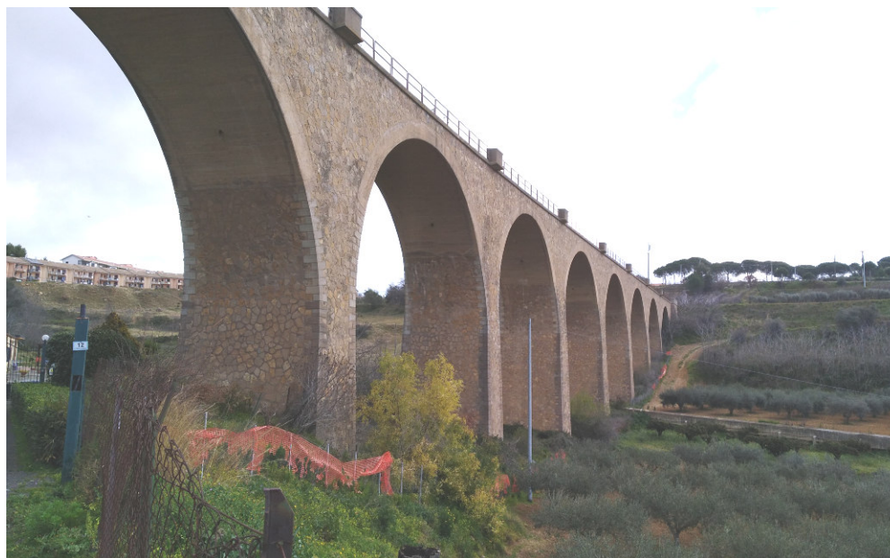
FIGURA 3: VIADOTTO VIADOTTO KM 318+516 - VISTA GENERALE DELL'OPERA
