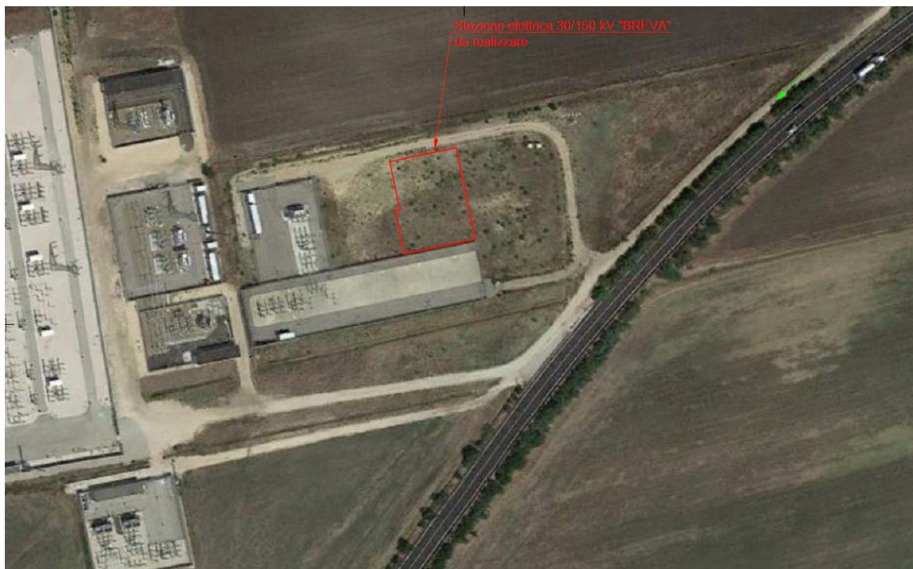
Figura 7 – Ripresa Aerofotogrammetrica Area stazione
