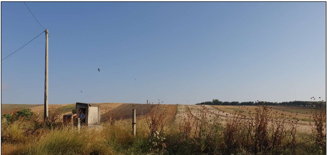
FOTO 14 – Area installazione WTG 14
