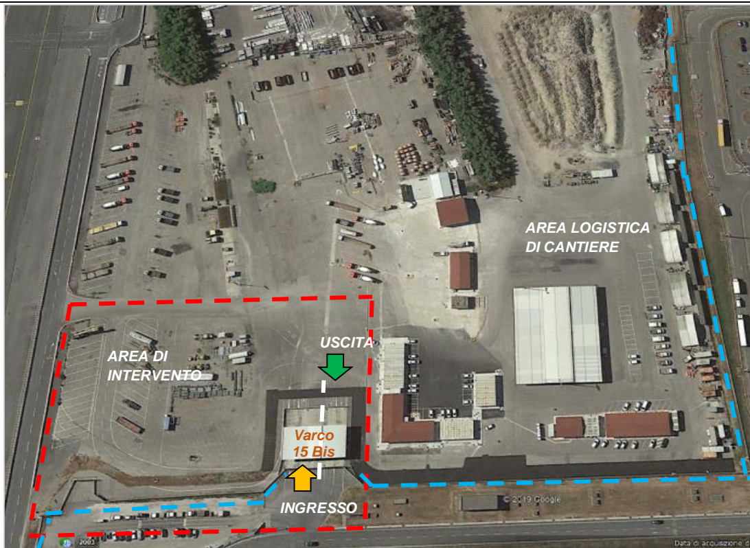
Figura 3-3 Focus area di intervento e area logistica di cantiere Sistema Aerostazioni lato Est (A.I. A e AVC T1)
