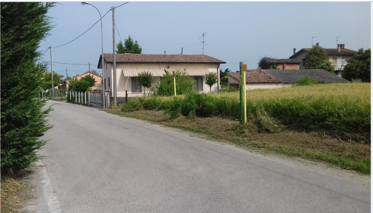
Figura 11 – Esempio di cartelli segnalatori del metanodotto
