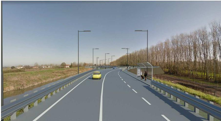
*Figura 10: Simulazione di progetto – area fermata autobus con marciapiede pedonale*
