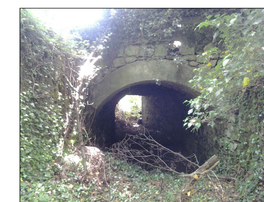
VISTA PONTE LATO MONTE
