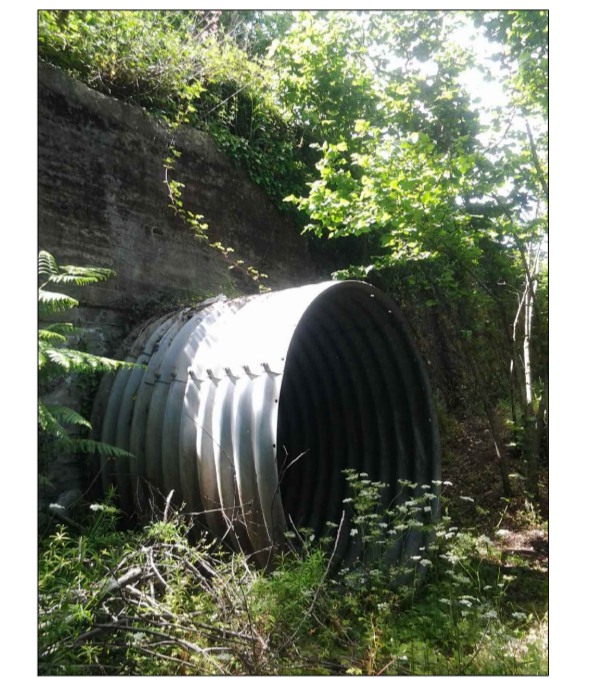
VISTA ATTRAVERSAMENTO LATO VALLE
