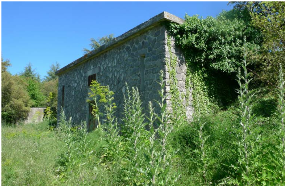
Figura 4.1 – Vasca Crasta Lada –camera di manovra (foto 2018)
