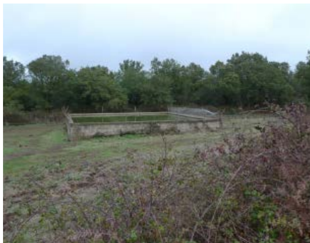
Foto 9: Vasca antincendio sulla strada di accesso al serbatoio Crasta Lada
