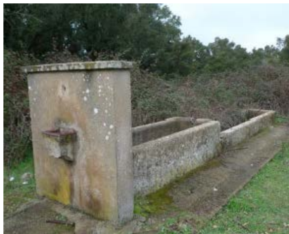
Foto 10: Abbeveratoio sulla strada di accesso al serbatoio
