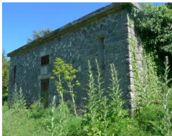
Foto 8: Serbatoio Crasta Lada facciata Nord
