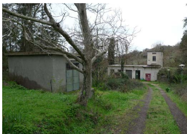
Foto 2: Impianto di sollevamento
