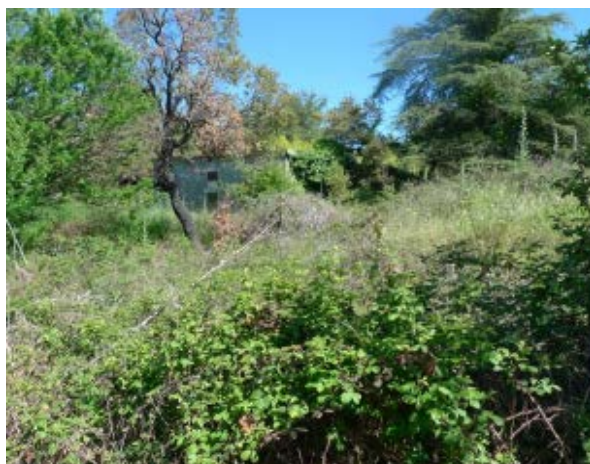
Foto 7: Serbatoio Crasta Lada vista da Nord
