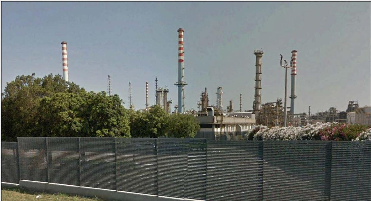
Figura 4.9.1.2a Vista da S.S. n.106 in direzione della Raffineria
