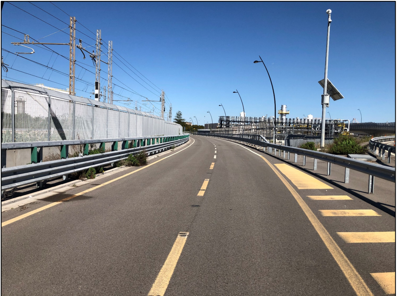
Figura 4.9.1.1b Tratto strada panoramica costeggiata da un muro
