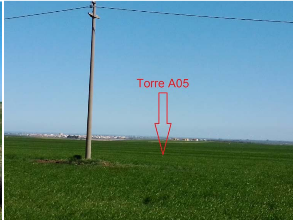
Foto 29 (Parco Eolico Torre A05)
