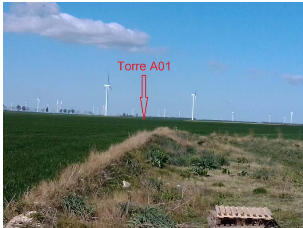
Foto 25 (Parco Eolico Torre A01)
