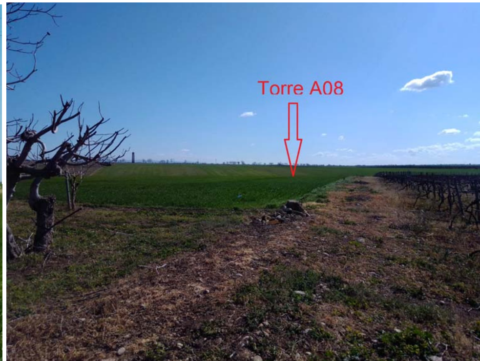
Foto 32 (Parco Eolico Torre A08)
